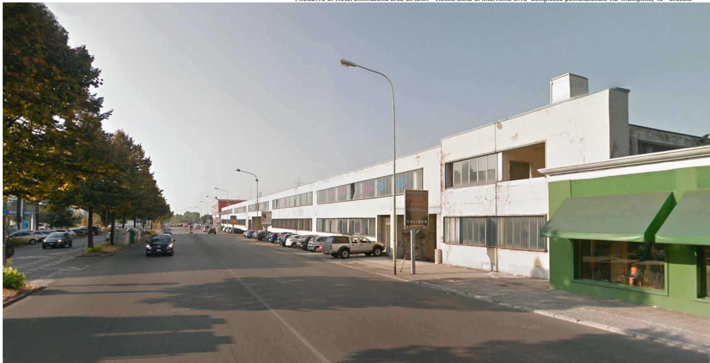
VISTA DA VIA TRIUPLINA ANTE OPERAM
