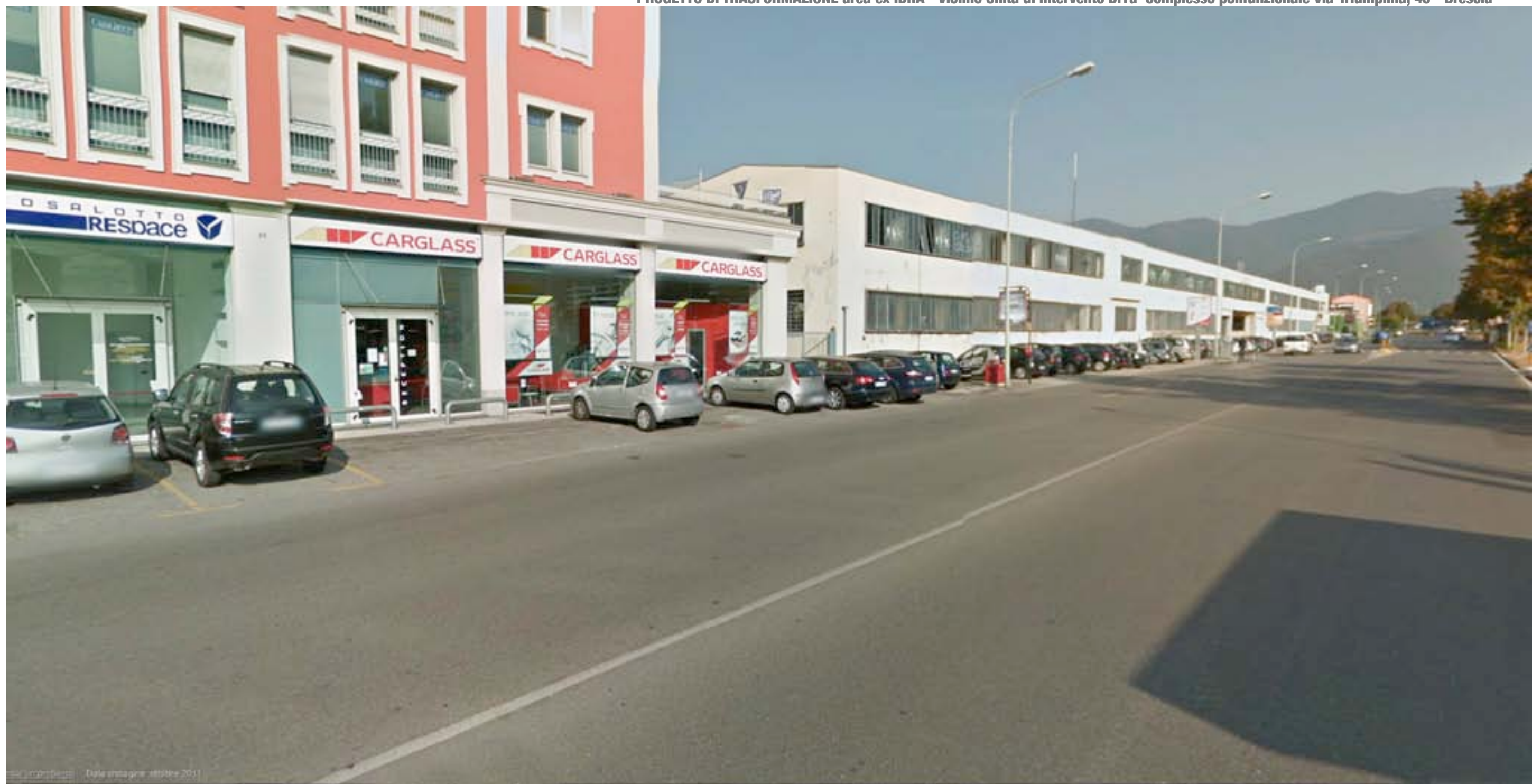
VISTA DA VIA TRIUPLINA ANTE OPERAM
