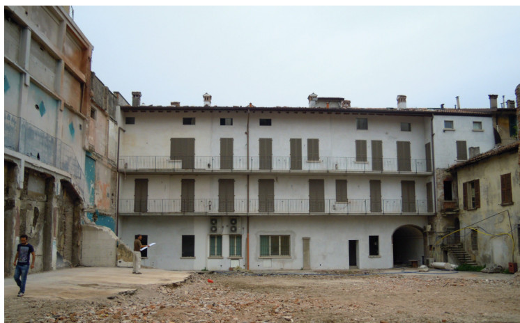
vista del corpo di fabbrica A. non oggetto d'intervento
