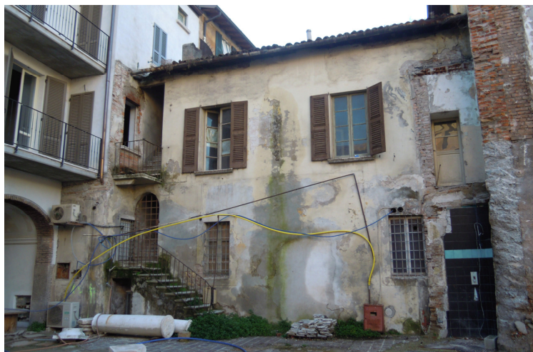
vista del corpo di fabbrica non demolito, edificio D
