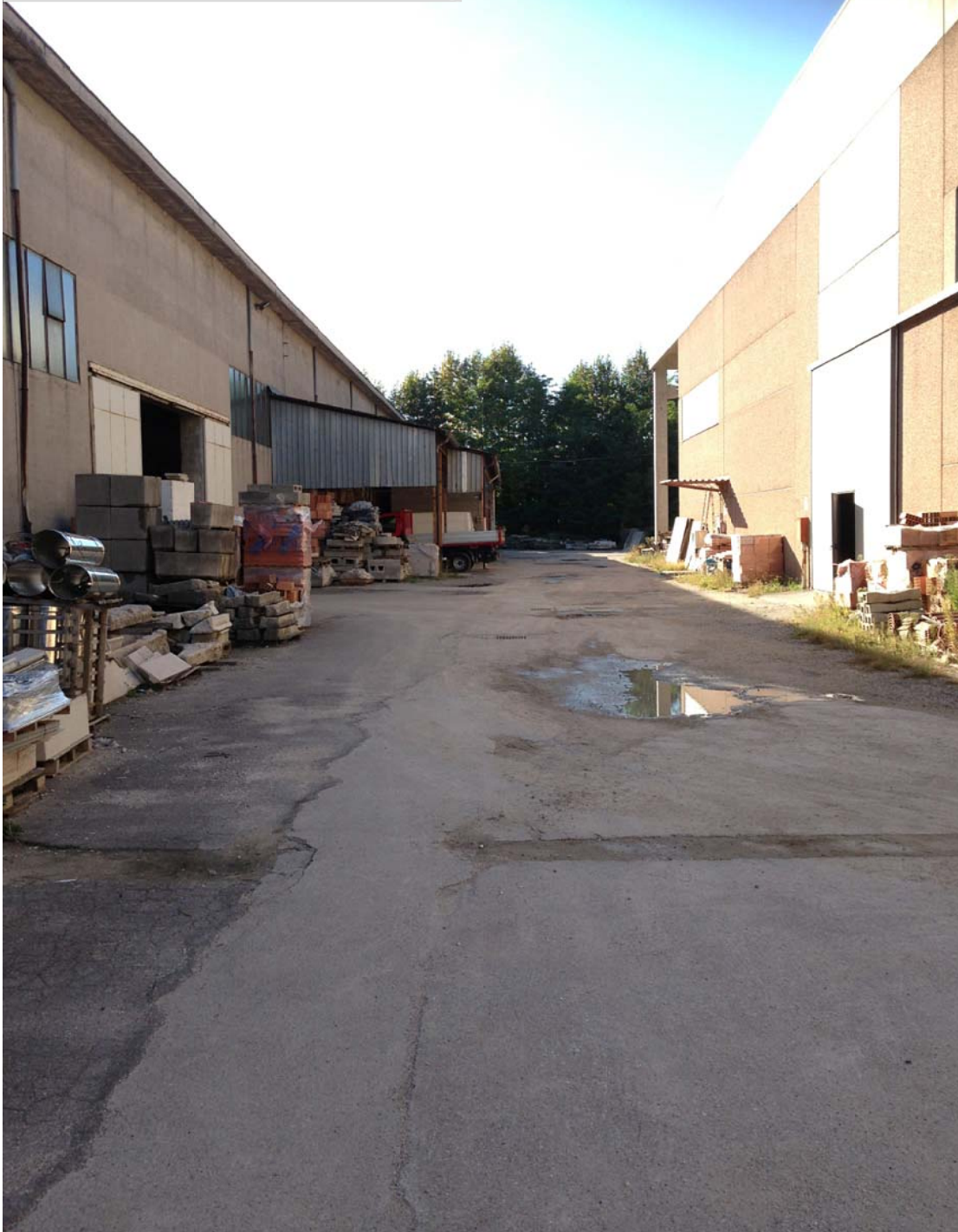
Punto di presa - 9
