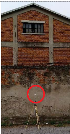
Mon.05B – Mon. 08E – Misura a circa 1 m dal muro di confine della ex Caserma - lato esterno, in corrispondenza del lato della Stazione dell'Alta Tensione più lontano dalla via Franchi.
