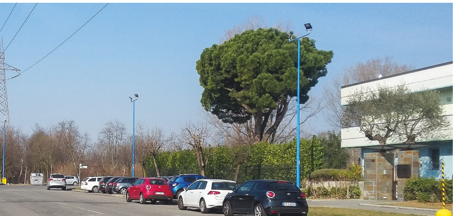
Immagine 2: Vista dell'elettrodotto da via Francesco Perotti.
