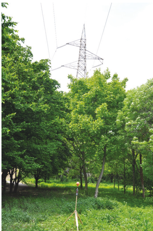
Postazione di misura 1
