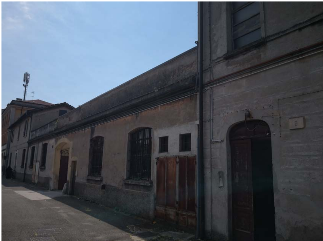
Facciata su via Pietro da Cemmo
