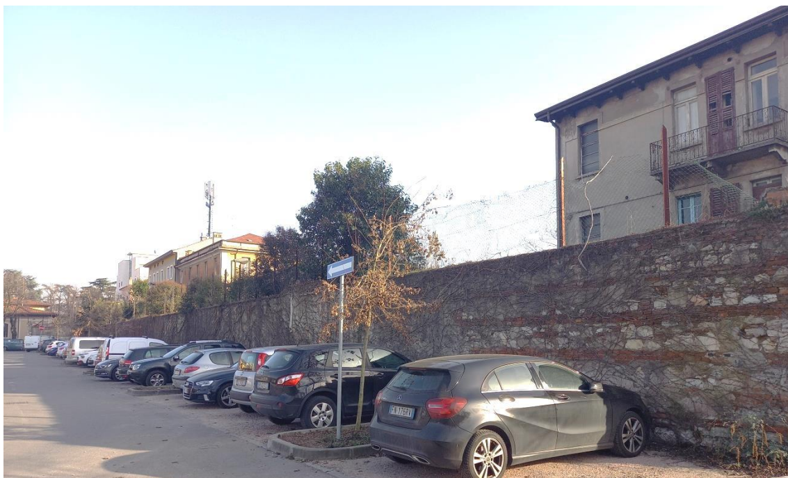
Fig. 6 – Visione esterna sul confine nord dell’area di intervento con parziale visione dei ligustri a contatto della muratura che verrà abbassata a circa 1m di altezza
