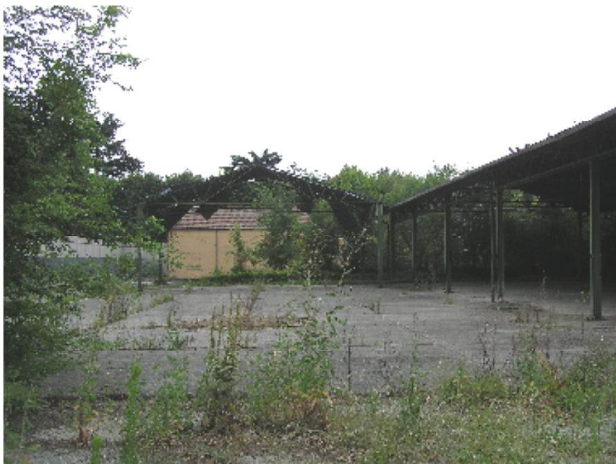
Foto 24 – Stato attuale – Angolo Via Volturno Via Camozzi. I corpi di fabbrica C1, C2 e C3 sono stati uniti a creare un solo blocco edilizio con pianta a C.
