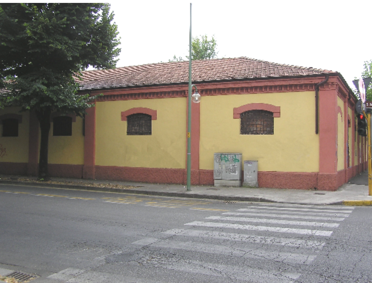
Foto 23 – 1892/ 1900 ? – Corpi di fabbrica verso Via Volturno angolo Via Camozzi C1 e C2. I corpi erano distintamen te separati.
