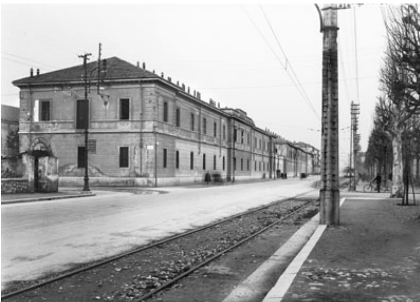
Foto 2 - 1945/50 ? - Il degrado della facciata, con visibili interventi di riparazione degli intonaci da possibili ferite belliche, e la presenza della linea tranviaria, rimasta attiva a Brescia fino agli anni '60, collocano questa immagine alla fine della seconda guerra mondiale.
