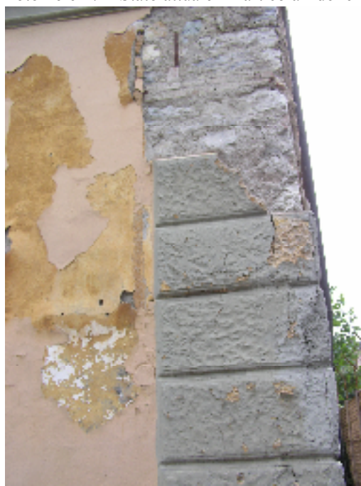
Foto 26 e 27 – Stato attuale – Particolari delle finiture degli intonaci esterni corpo C prima e dopo la sistemazione.
