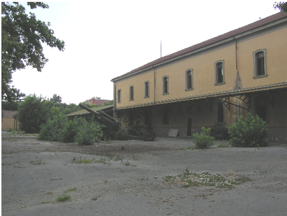
Foto 18 – Stato attuale – Palazzina Comando e Servizi costruita tra gli anni 1950 e 1970.
