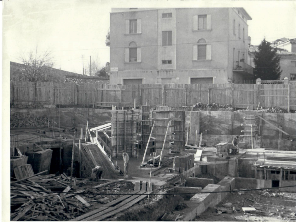
Scavo di fondazione e realizzazione muri controterra lato via Callegari
