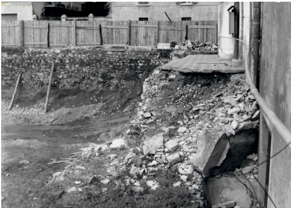
Scavo di fondazione e realizzazione muri controterra lato via Callegari
