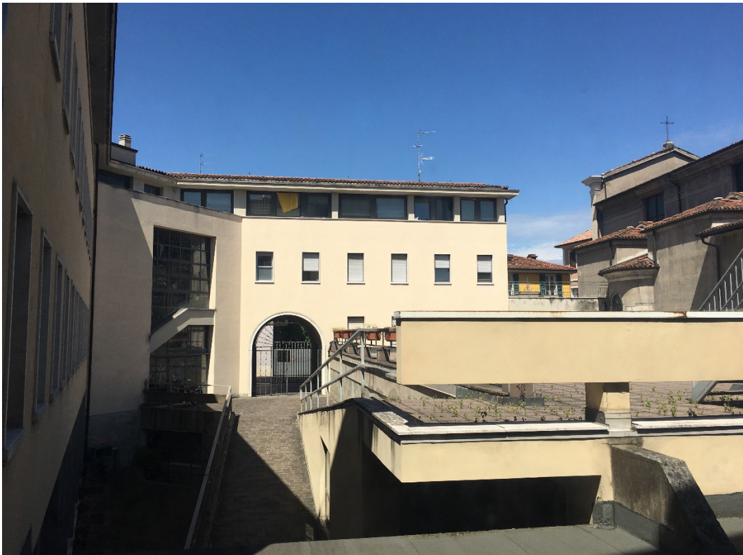
Foto Corte interna Blocco A
