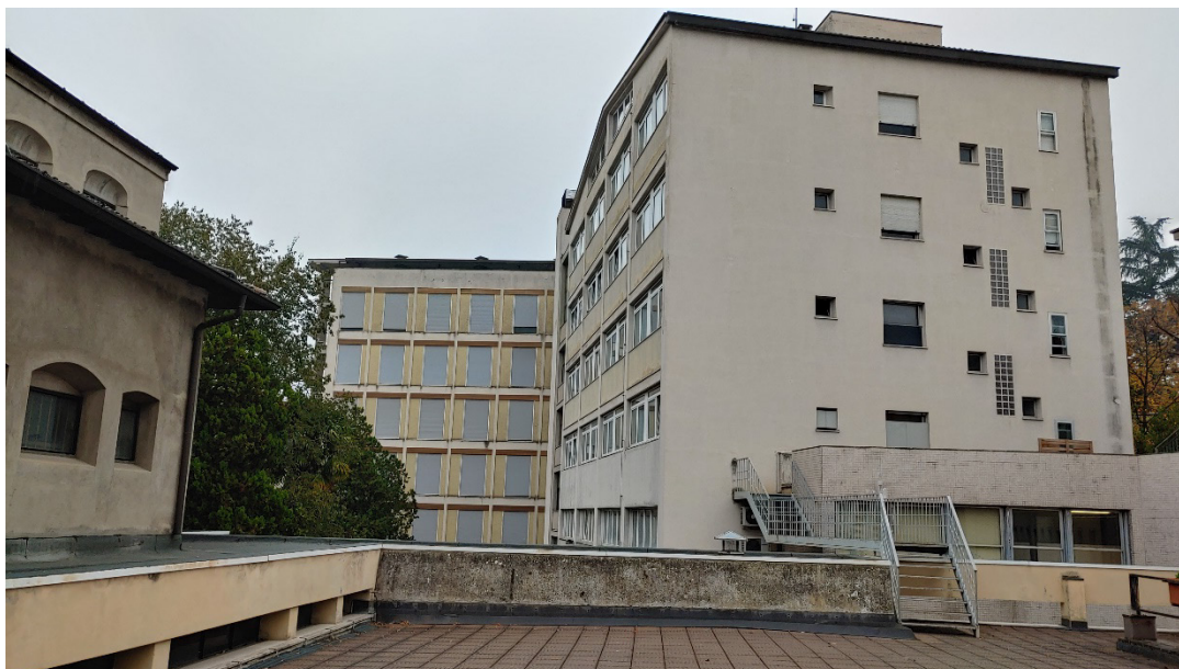
Foto Corte interna Blocco B e C
