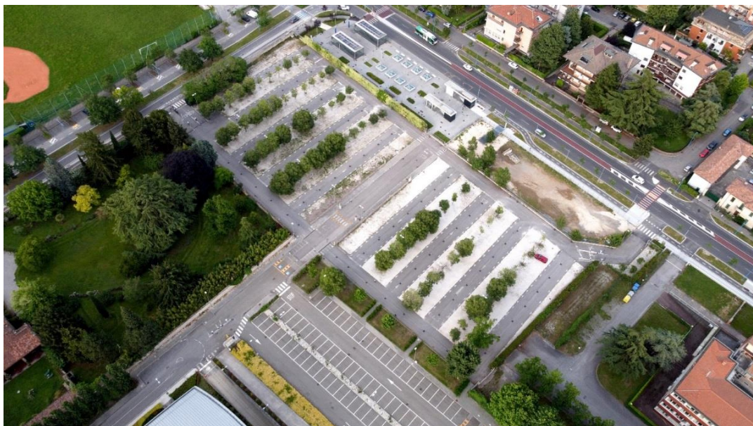
Figura 24 - Fotografia aerea sedime edificio B
