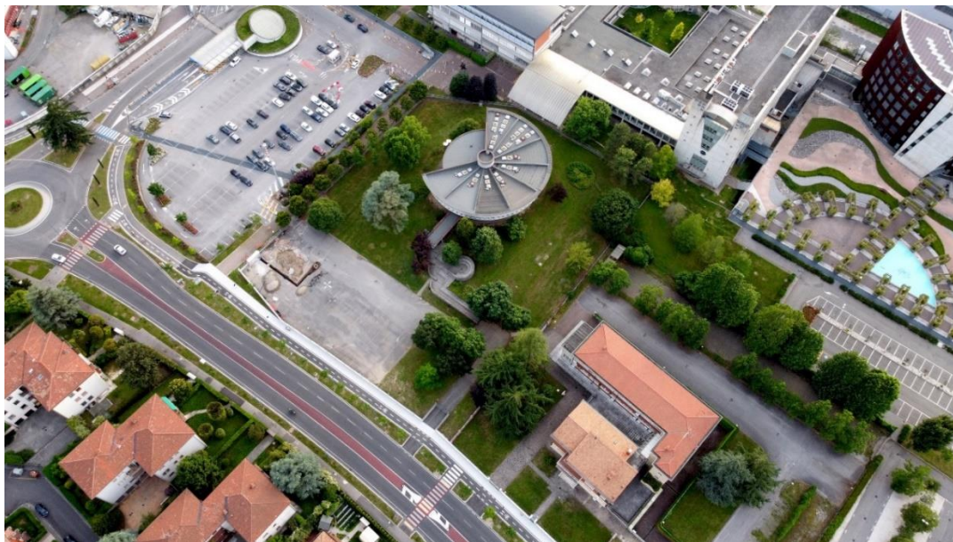
Figura 26 - Vista aerea sedime edificio C
