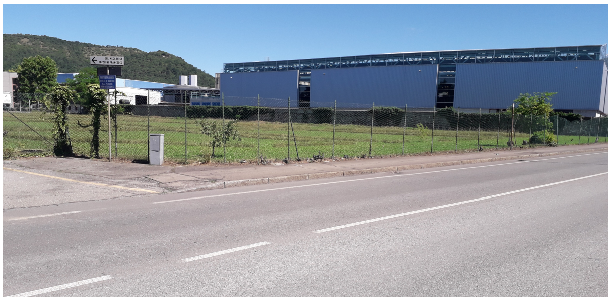
Vista del tratto sud del marciapiede di via scuole da allargare.
