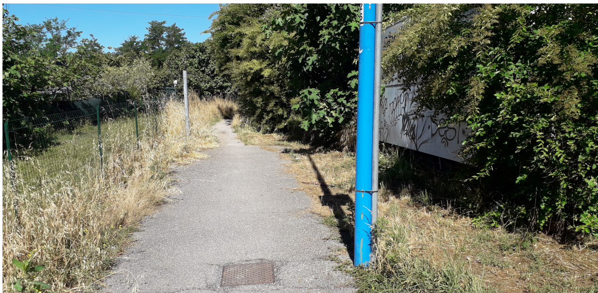
Tratto terminale di pista ciclabile già asfaltato e tratto da asfaltare.
