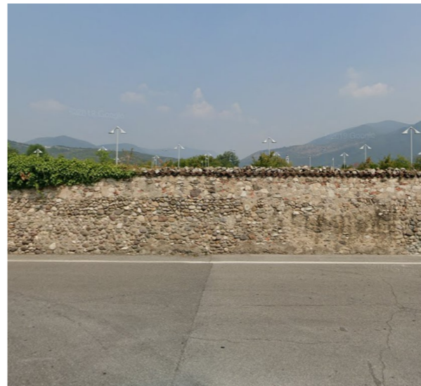
Muro storico in pietre di fiume
