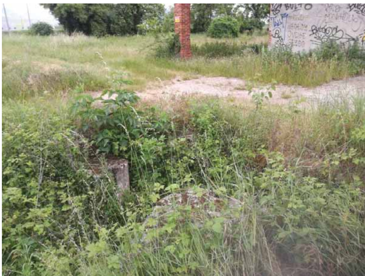
Foto_6: spalle della paratoria di deviazione del flusso idrico oggi in disuso
