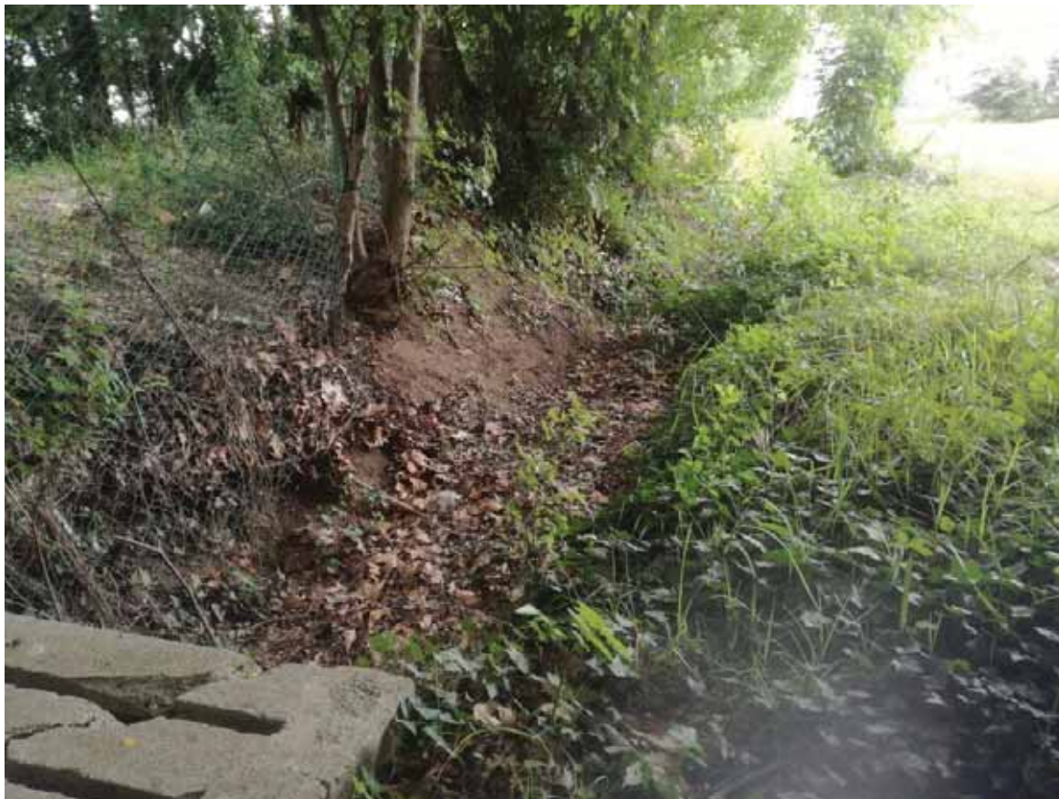
Foto_1: canale irriguo che da Via Buffalora tramite paratoia conduce le acque della Roggia Caionvica ai terreni di proprietà CEMBRE
