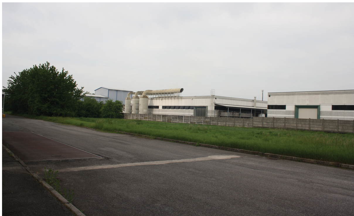
fotografia n.4 - vista dell'area di intervento da est verso sud-ovest
