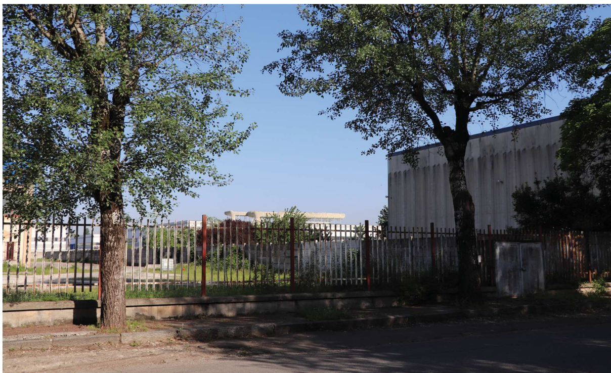
fotografia n.12- vista dalla via Gussalli dove verrà realizzata l'uscita carraia di progetto
