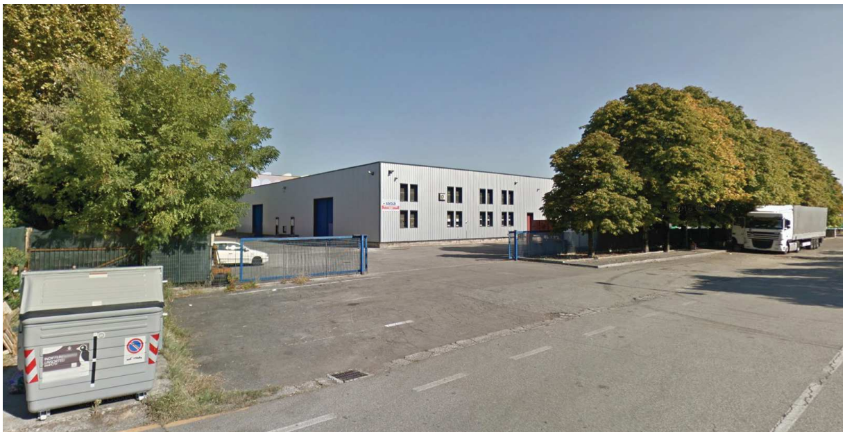
fotografia n.16 - vista di un edificio produttivo esistente che si affaccia sulla via del Serpente
