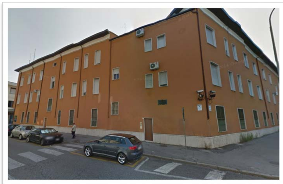
Ripresa n.2 Edificio speciale civile
