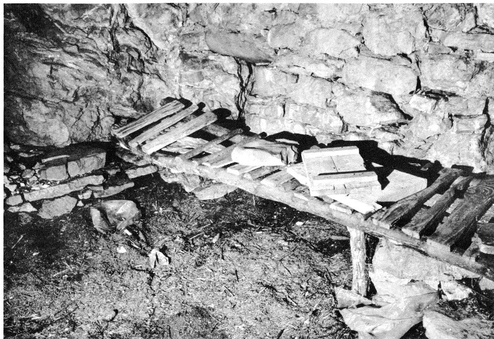
Fig. 21-23 - Bús del Lat de Casina Tomàs . 21: l'ingresso nella profonda trincea d'approccio "a L", sovrastato dalla volta occultata dalla spessa cotica erbosa. 22: la porta d'ingresso vista dall'interno; 23: particolare degli appoggi per i recipienti del latte (15.V.1981).
