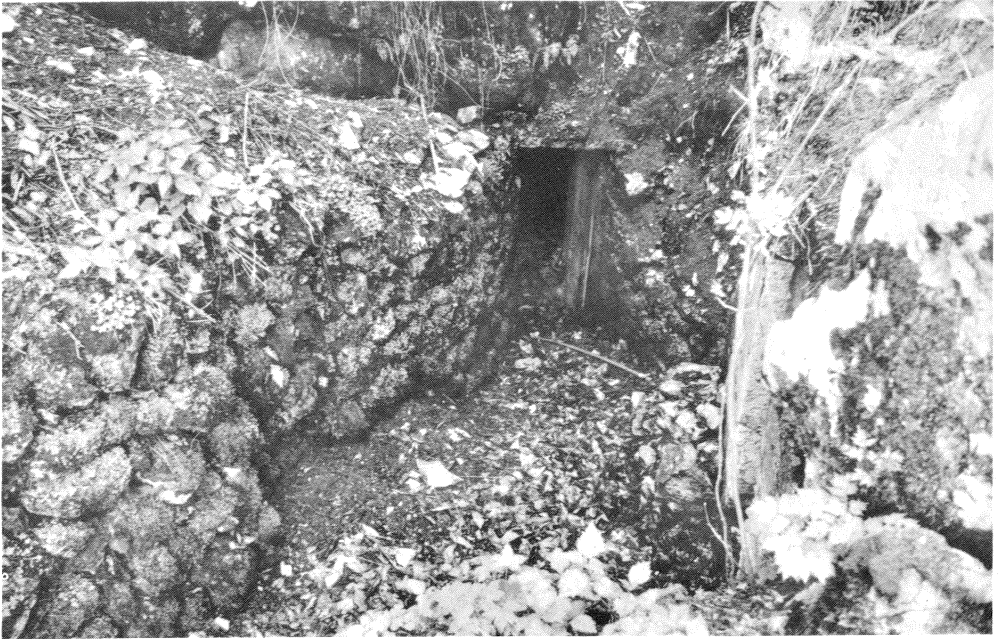
Fig. 18 - Büs del Lat de Casa Ceri (n. 19 Lo): la trincea d'approccio e, sul fondo, l'ingresso della cavità naturale adattata con porta (15.V.1981).
