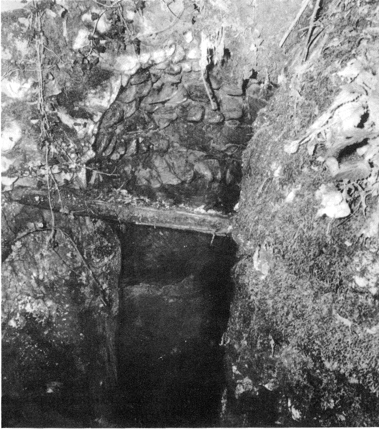
Fig. 33 - Ómber de Calamór (n. 64 Lo): particolare della volta a catino che sovrasta l'architrave dell'ingresso (29.V.1981).
