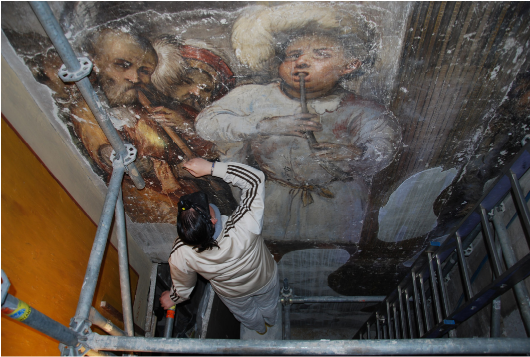
Fase della discialbatura (lato sx) eseguita con bisturi chirurgico (Foto Mariani 2018)
