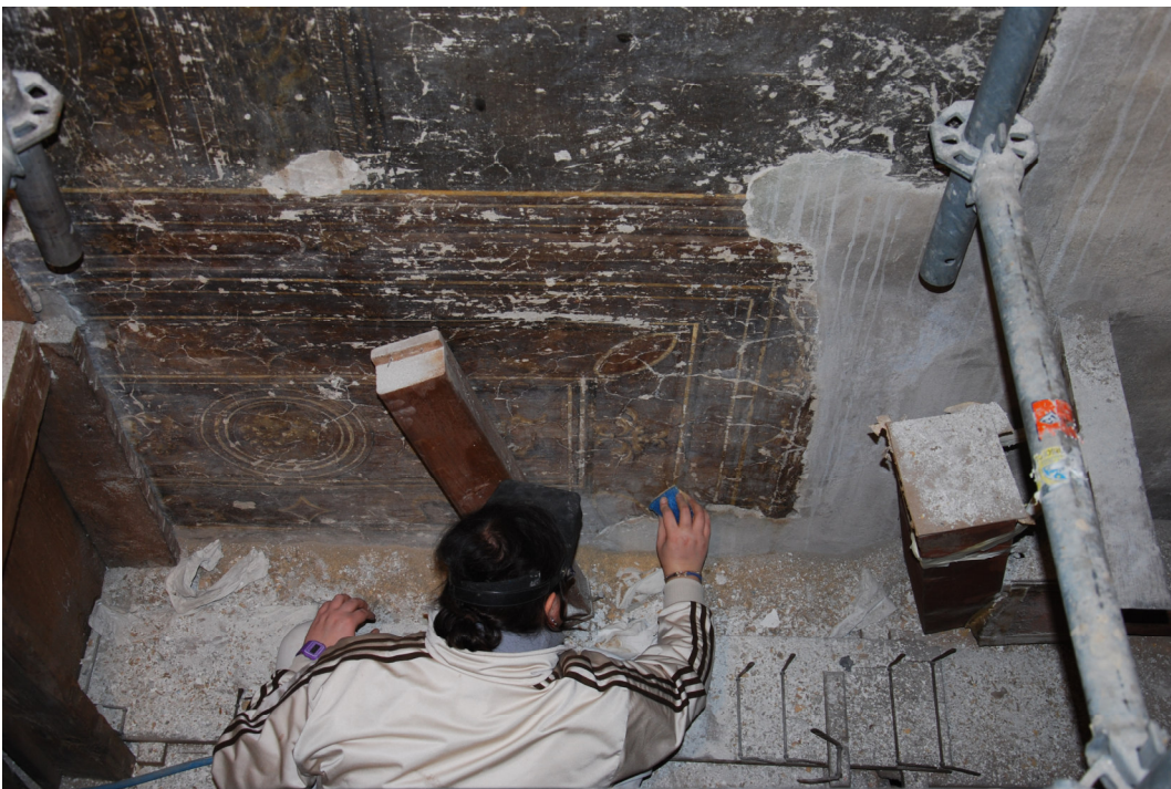
Fase della successiva pulitura con spugna wishab di tipo morbido (Foto Mariani 2018)
