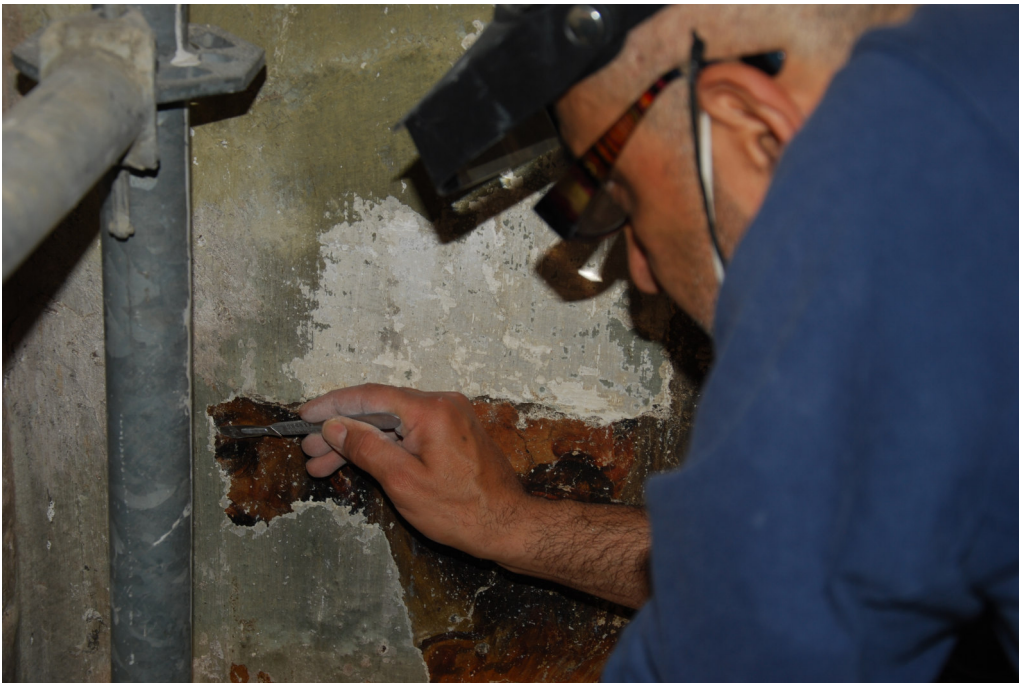
Fase della discialbatura (lato sx) eseguita con bisturi chirurgico resa in alcuni punti particolarmente complessa per la presenza dei montanti del ponteggio (Foto Mariani 2018)
