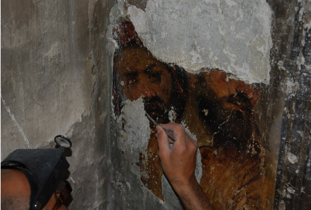
Fase della discialbatura (lato sx) eseguita con bisturi chirurgico a lame intercambiabili (Foto Mariani 2018)
