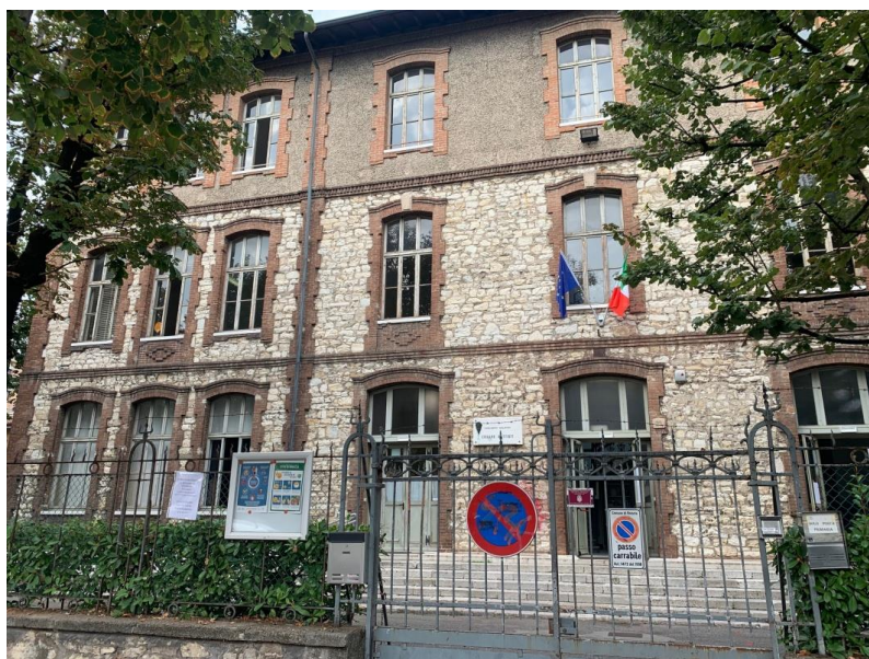
Foto 1: Vista ingresso su via Trento
