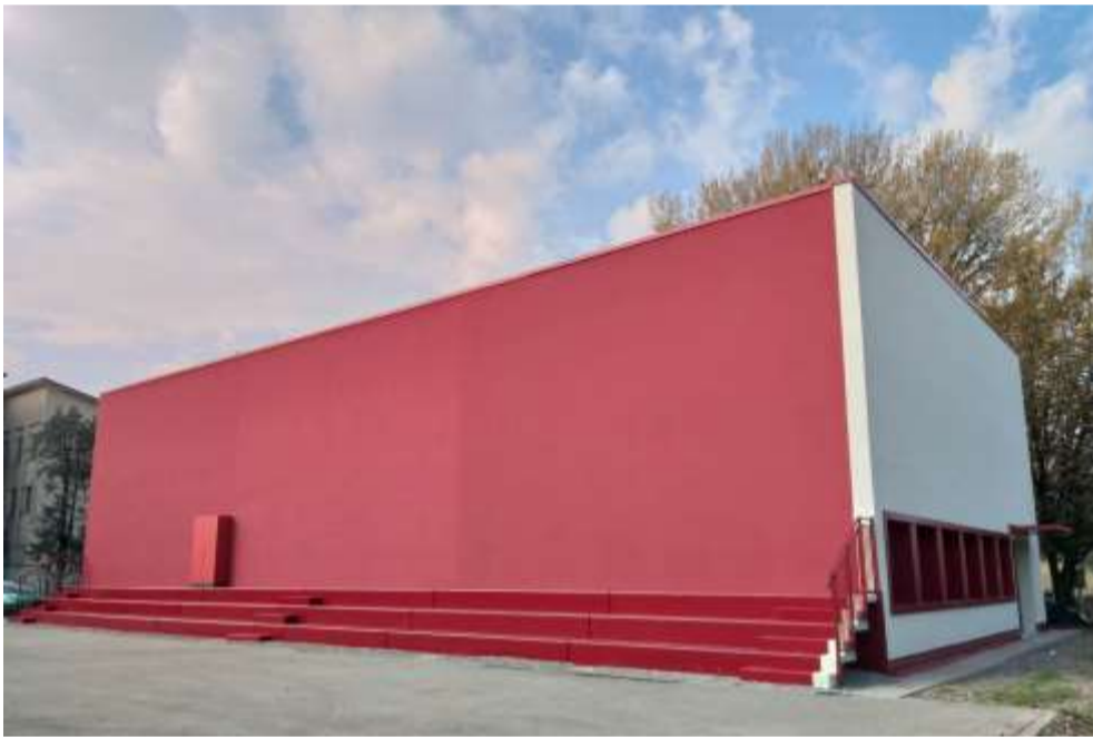
Fig. 6– Facciata EST , post intervento
