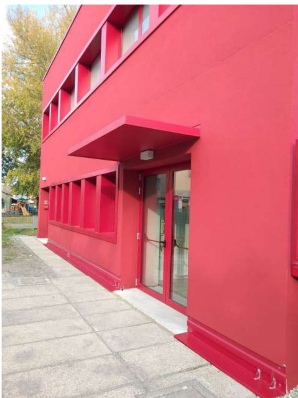
Fig. 7– Facciata SUD post intervento
