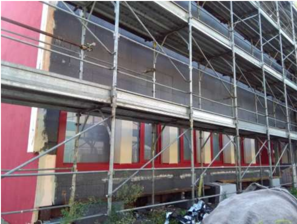
Fig. 5– Esecuzione dei lavori – realizzazione isolamento a cappotto
