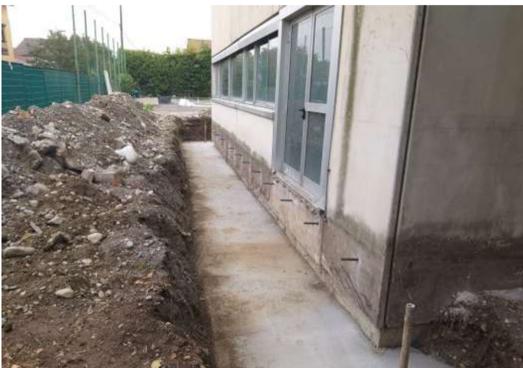
Fig. 2 – Esecuzione dei lavori – realizzazione fondazioni telaio strutturale
