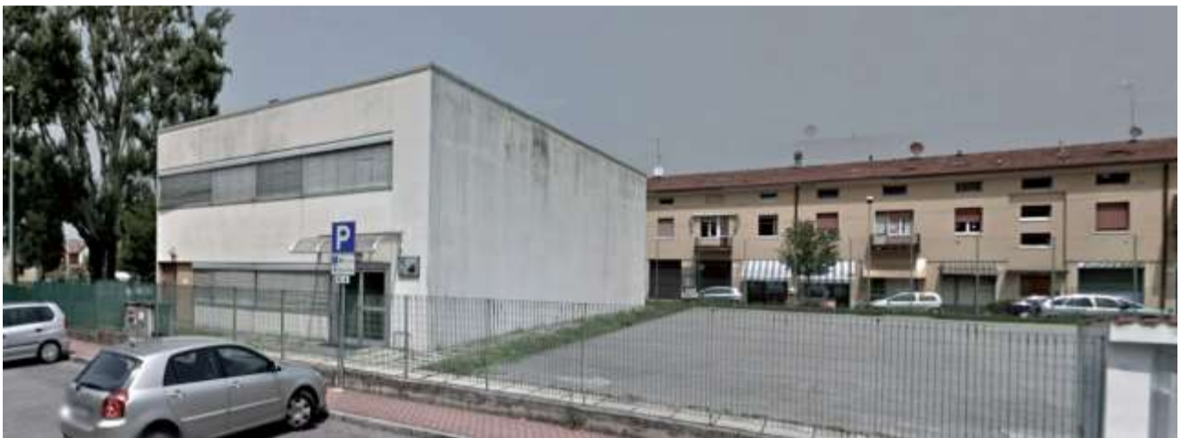
Fig. 1 - Situazione prima dell'intervento
