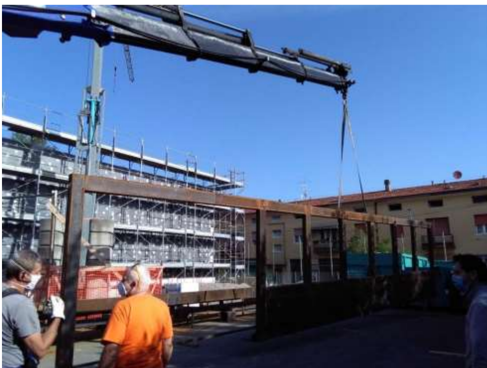
Fig. 4 – Esecuzione dei lavori – telaio strutturale
