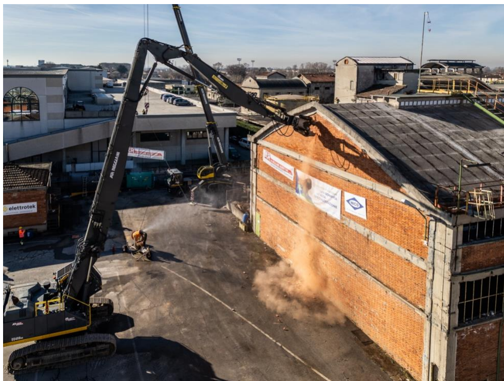
Figura 1: Demolizione primo edificio Caffaro
