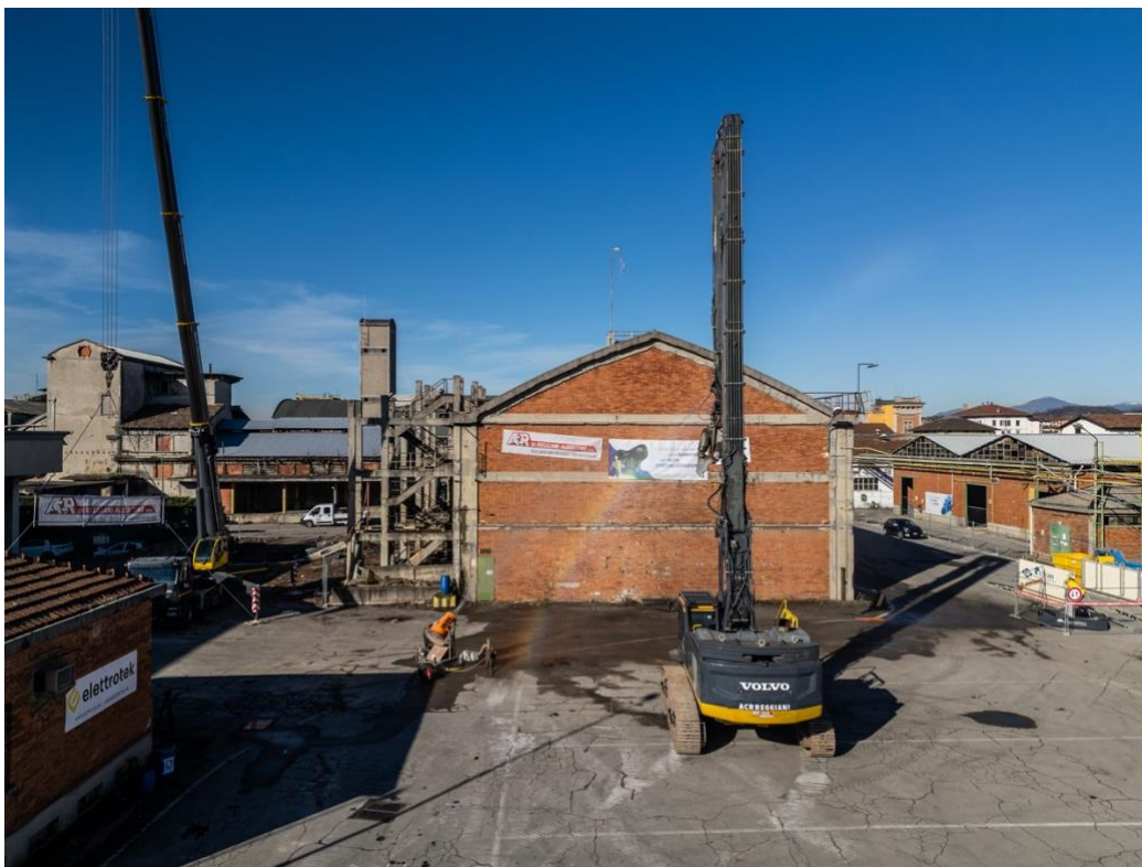
Figura 2: Demolizione primo edificio Caffaro
