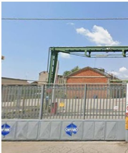
Figura 1: Edificio oggetto di demolizione
