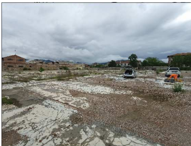
Foto n. 1 – vista interna verso est (verso via Villa Glori)
