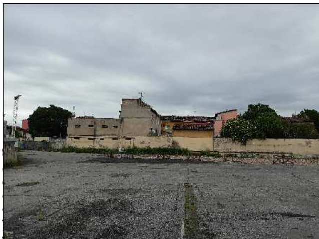
Foto n. 11 – vista interna verso nord (verso via Milano)
