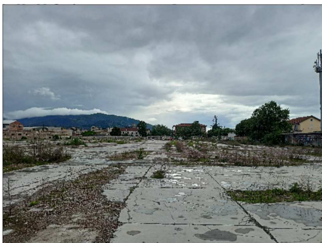
Foto n. 10 – vista interna da ovest verso est
