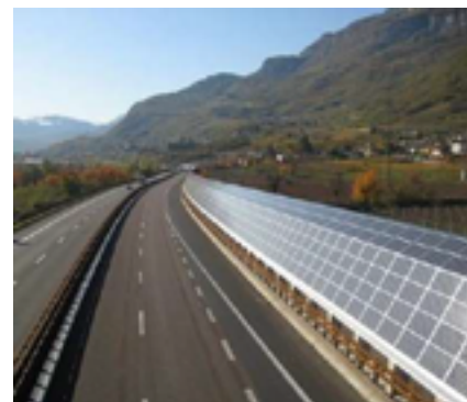
Autostrada del Brennero, integrazione tra barriera antirumore e pannelli fotovoltaici.
