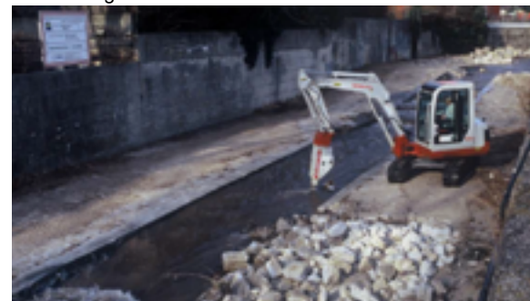
DURANTE LA DEMOLIZIONE DELL'ALVEO IN CEMENTO
