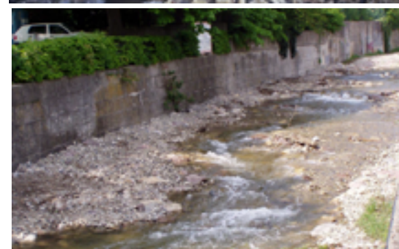
APPENA DOPO LA COSTRUZIONE DI UNA RAMPA SINUOSA IN MASSI CICLOPICI 3 / 2006
