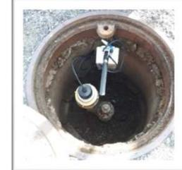
Vantaggi rispetto alla ricerca tradizionale: la ricerca eseguita tramite squadre di ricerca perdite mediante sistema acustico oltre a risentire della presenza di rumori esterni che possono compromettere l'ascolto permette solo una rilevazione momentanea e non continua.
