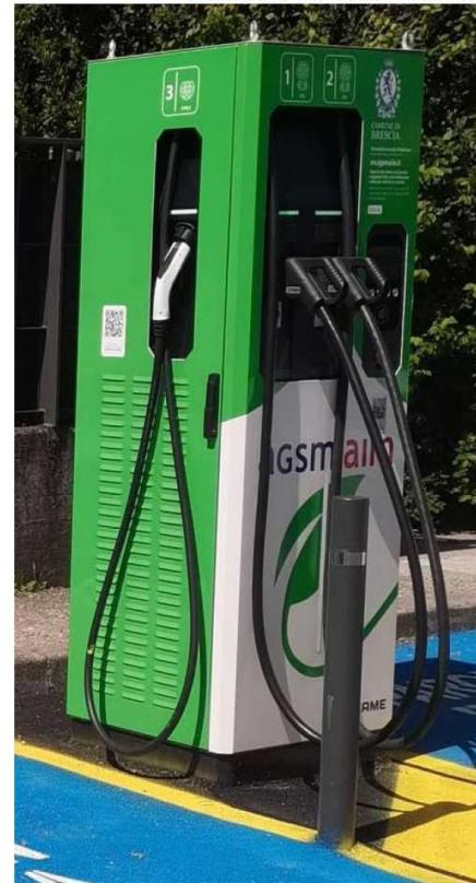
Le caratteristiche per le stazioni AC 1x43 KW + DC 1x50 KW sono:
