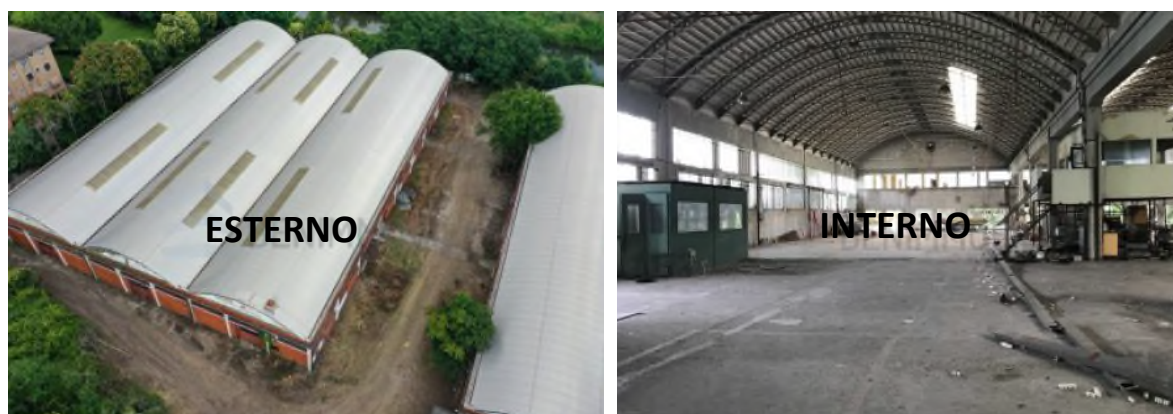
Figura 33. Viste del capannone
