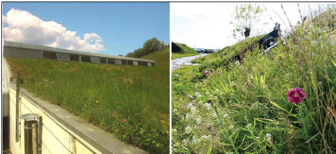
Tetto verde estensivo: prato naturale soluzione estensiva non fruibile
