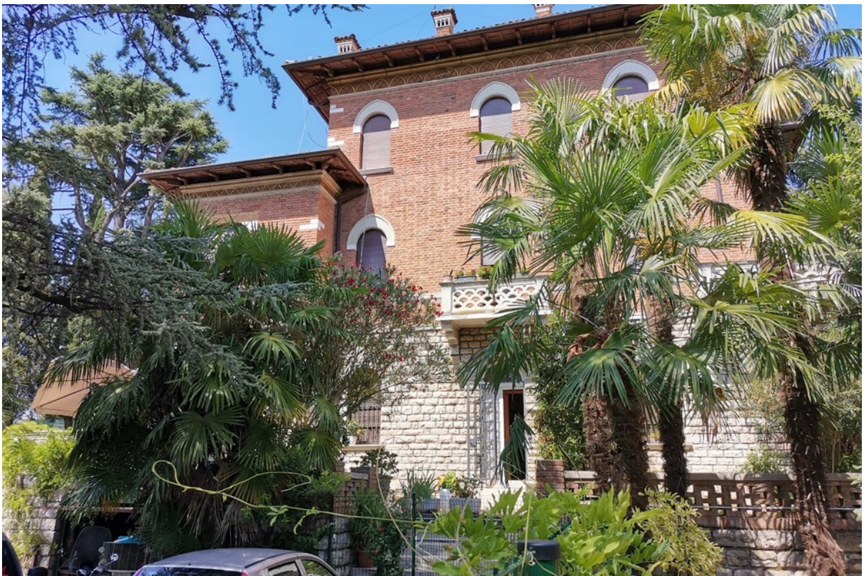
PALAZZINA - FRONTE SUD
