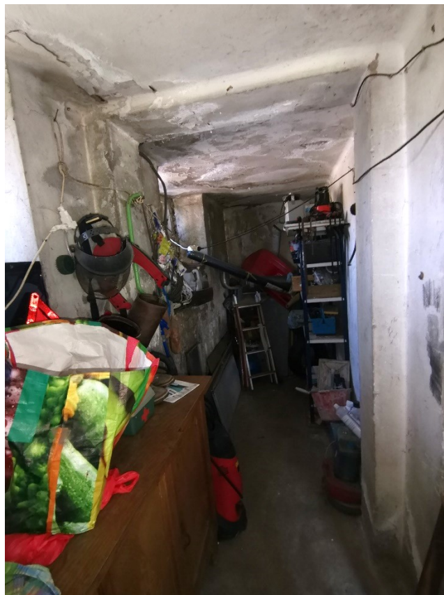
autorimessa 1 - VANO LATERALE A OVEST
