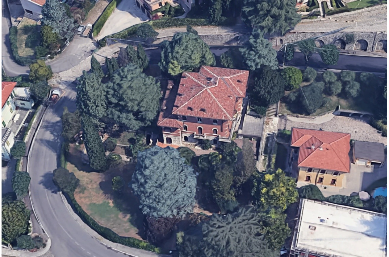
VISTA AEREA DA SUD
