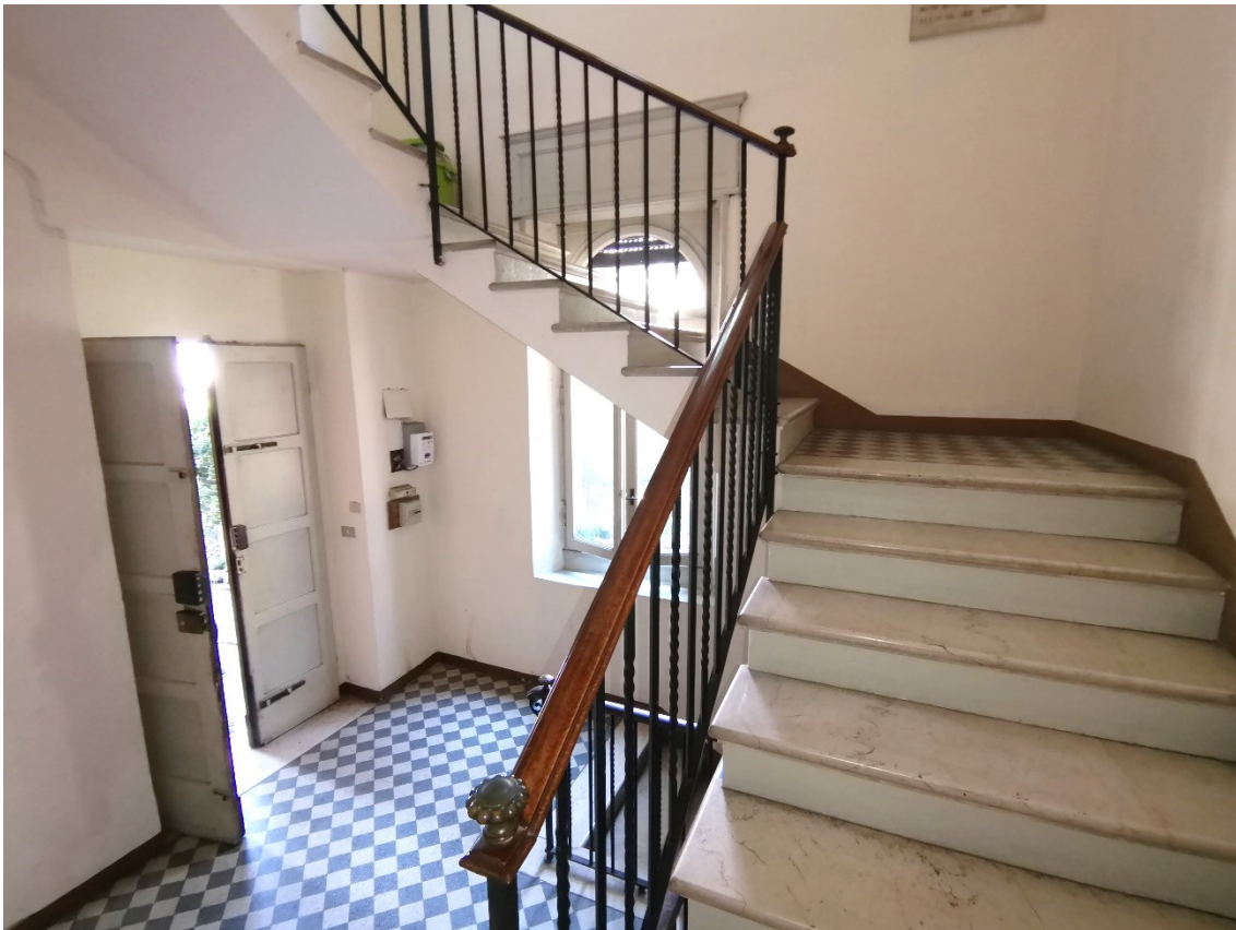
INGRESSO DEL VANO SCALE COMUNE AL PIANO TERRA
