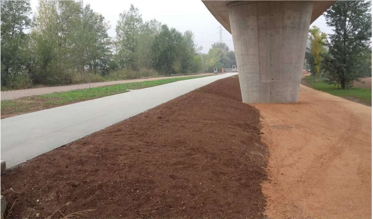
Percorso ciclopedonale di ingresso al Parco a Sanpolino – Intervento A.3
