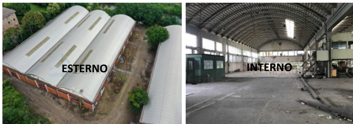
Figura 33. Viste del capannone
