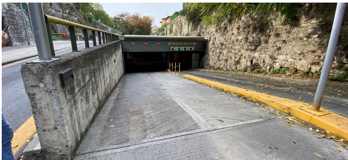
Figura 35. Parcheggio fossa bagni – stato attuale rampa da demolire
