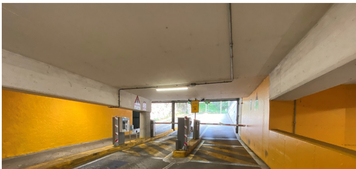
Figura 36. Parcheggio fossa bagni – stato attuale solaio da demolire
