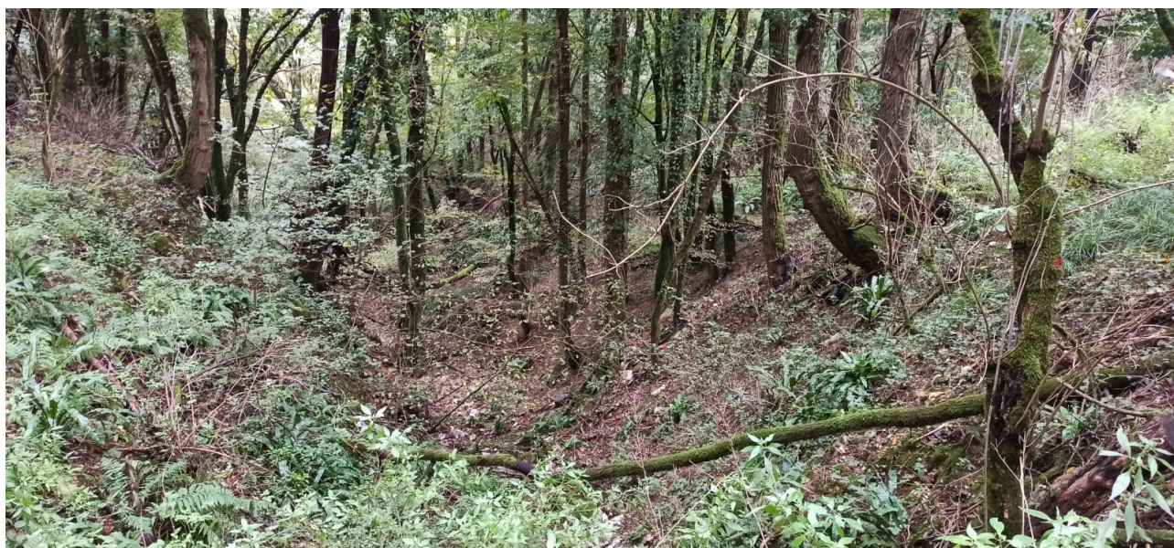
Vista a valle del nuovo tombotto: numerosi alberi appesi in scarpata con schianti da vento.
