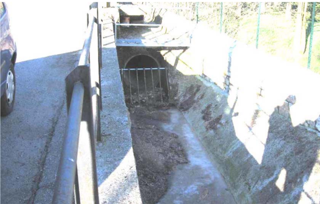
Figura 4: Inizio del tratto intubato.
