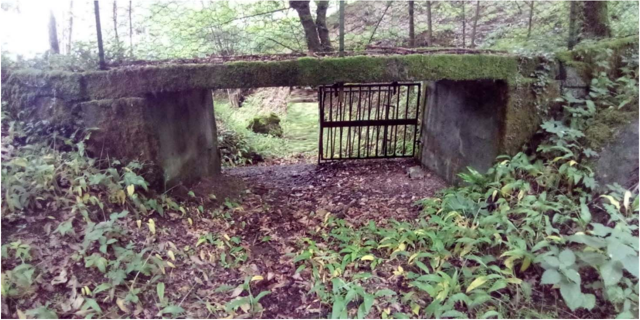
Figura 21: Manufatto di attraversamento della recinzione dell'ex-polveriera.
