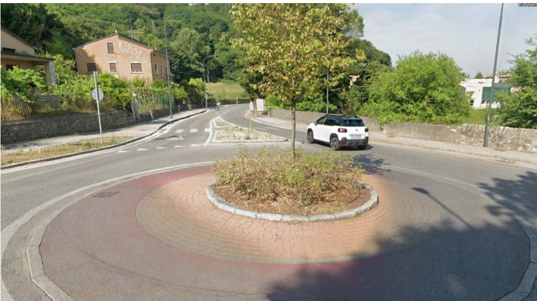
Figura 6: Rotonda tra Via Maiera e Via Costalunga.
