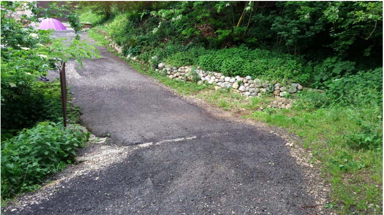
Figura 23: Guado sul Rio Cascina Termini.
