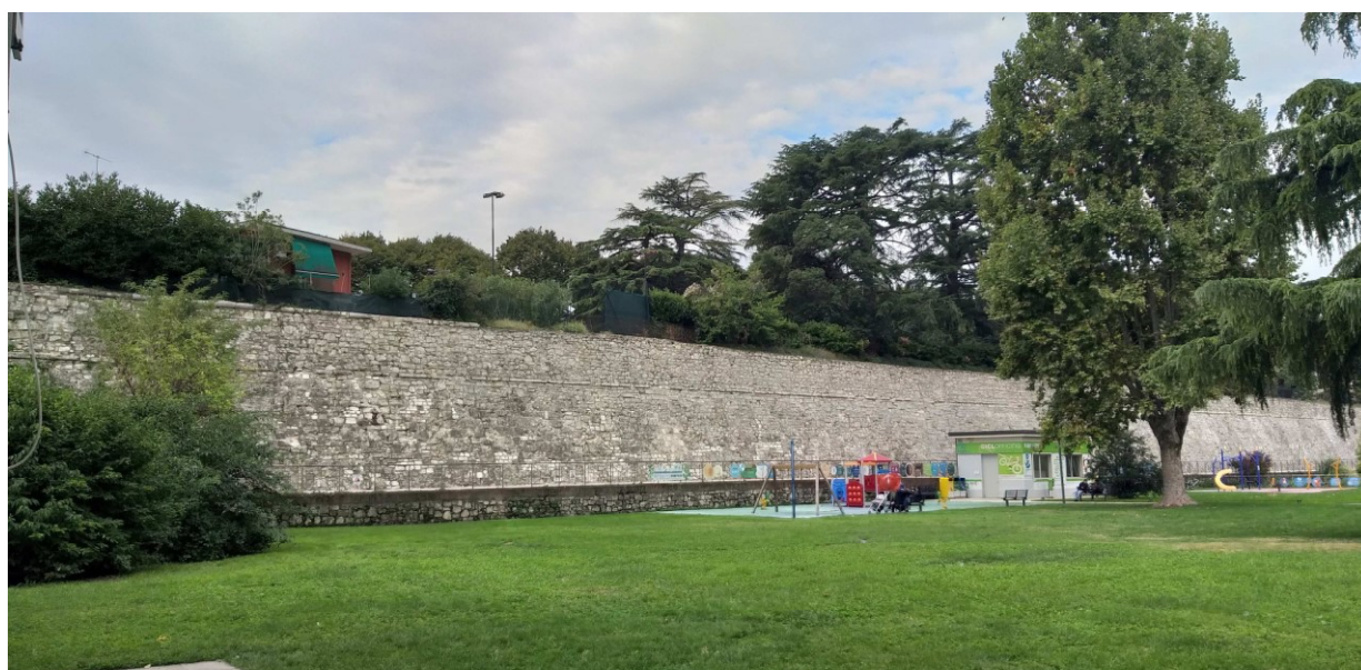
Il Tratto "C" – al termine dei lavori
