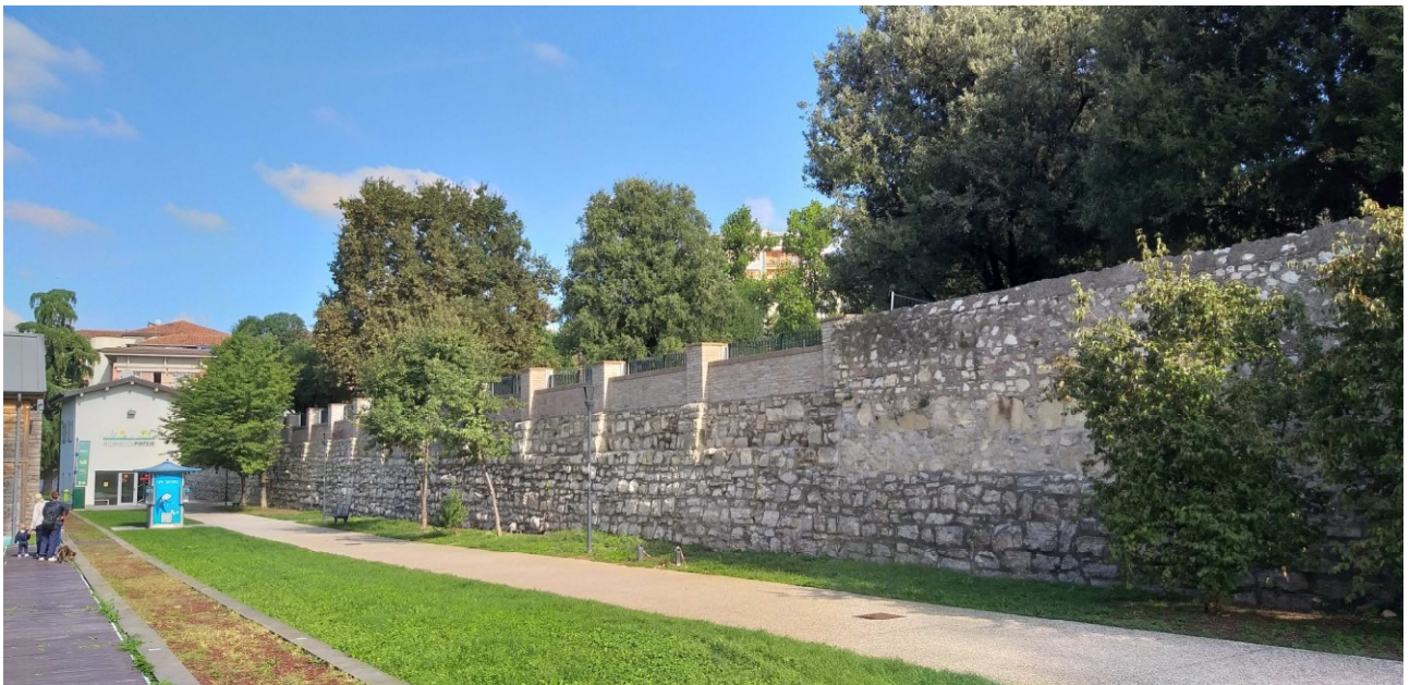
Il muro verso via Lechi– al termine dei lavori
