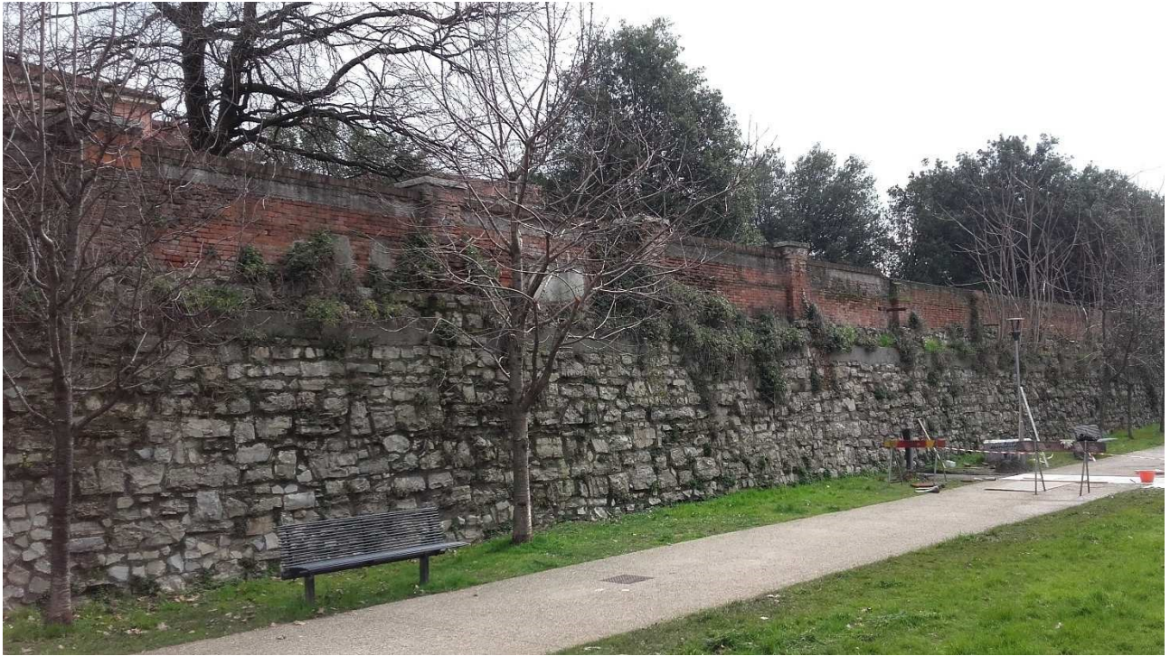
Il muro verso via Lechi– prima dei lavori
