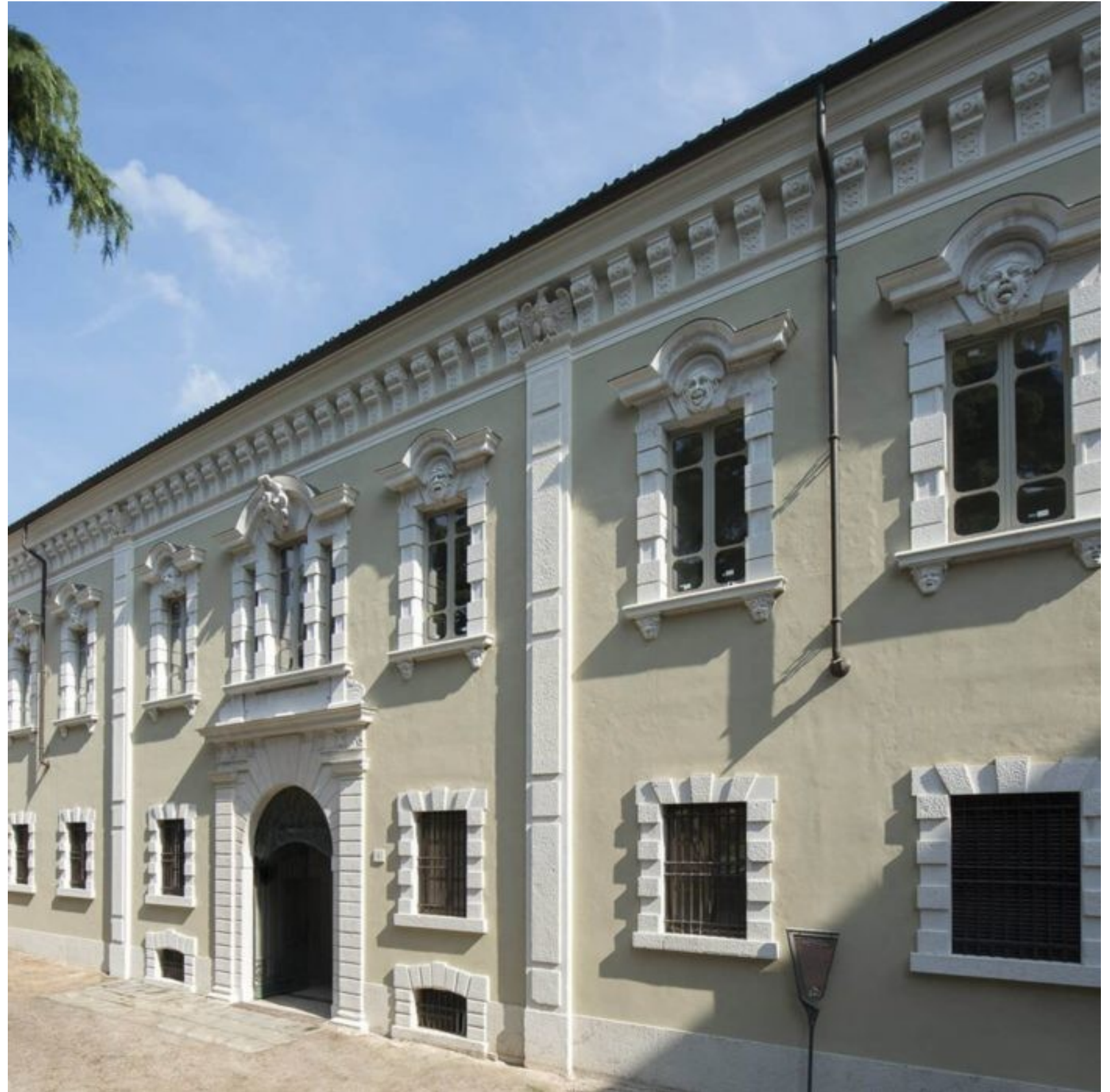
Vista complessiva del prospetto dopo l'intervento di restauro
