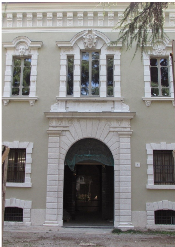
Il portale di ingresso dopo l'intervento di restauro
