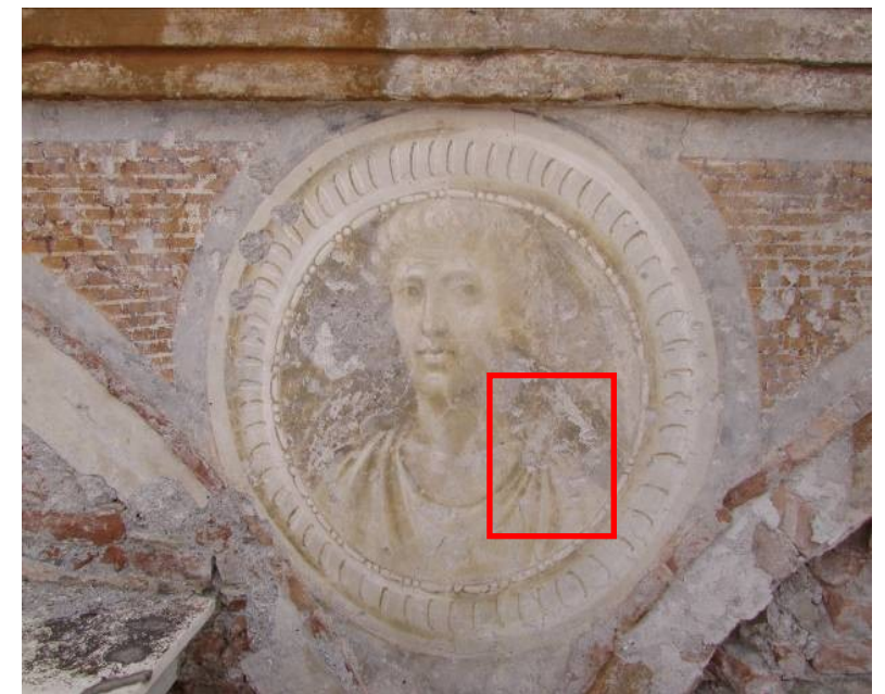
Vista dopo gli interventi di rimozione degli intonaci moderni
