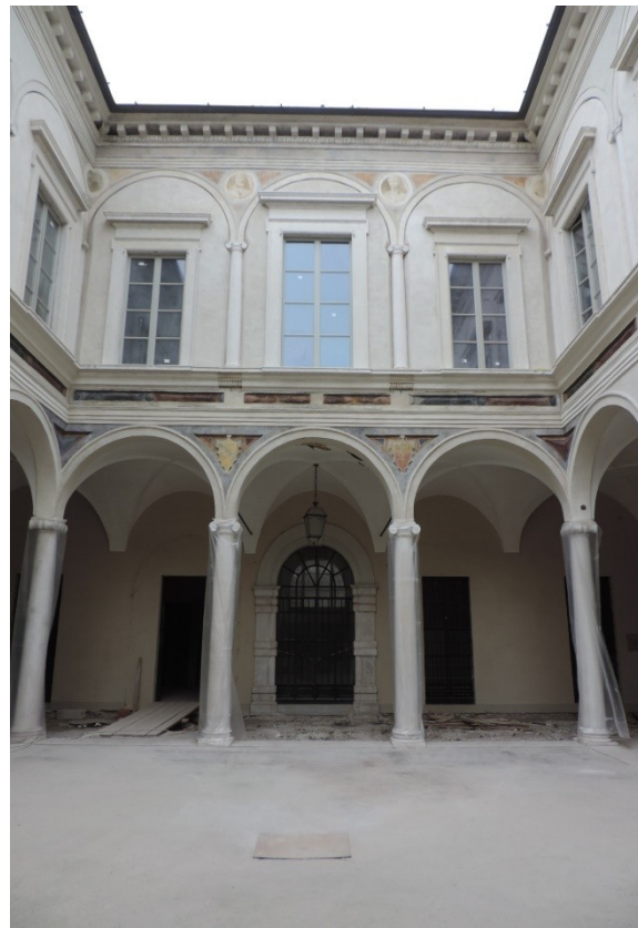
Vista dopo gli interventi di rimozione degli intonaci moderni
