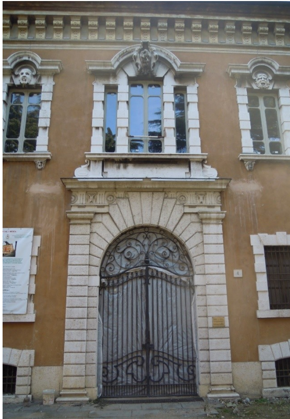
Il portale di ingresso prima dei lavori
