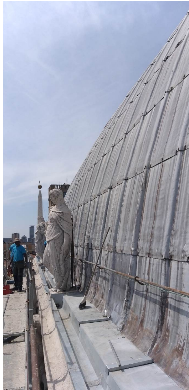
GRONDA EST - DOPO
