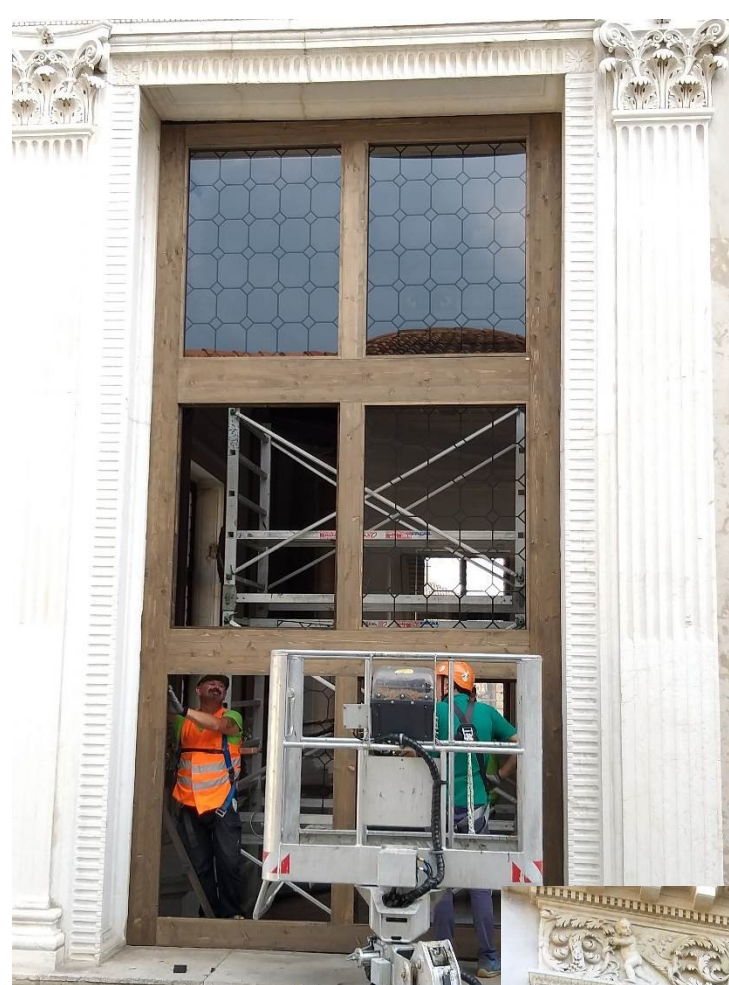
MONTAGGIO SERRAMENTO SOSTITUTIVO PROVVISORIO
