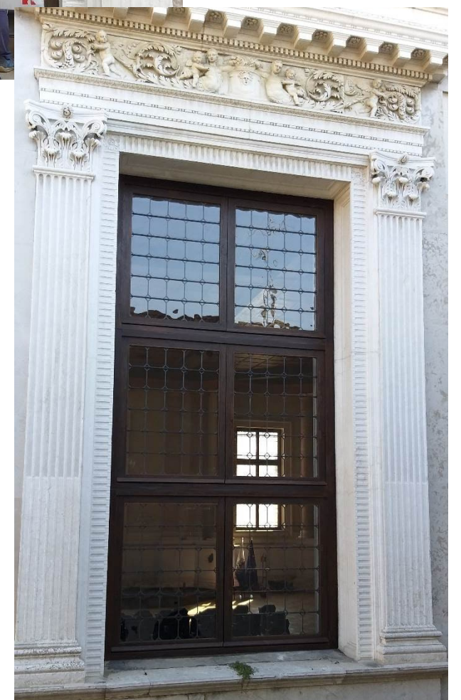
SERRAMENTO DOPO IL RESTAURO
