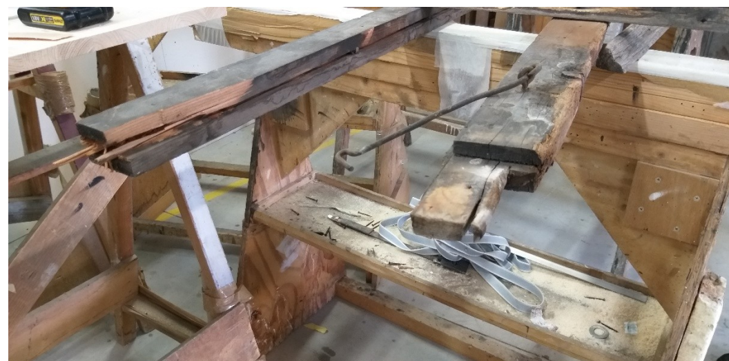
SERRAMENTO IN LABORATORIO – DEGRADO DEL LEGNO
