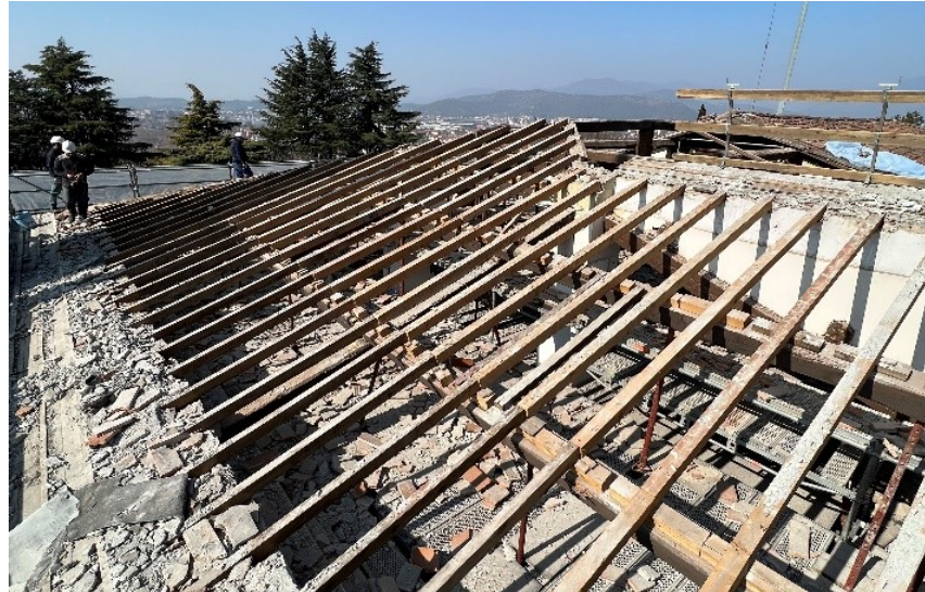
Situazione al momento della rimozione dell'assito, tavelle e massetto
