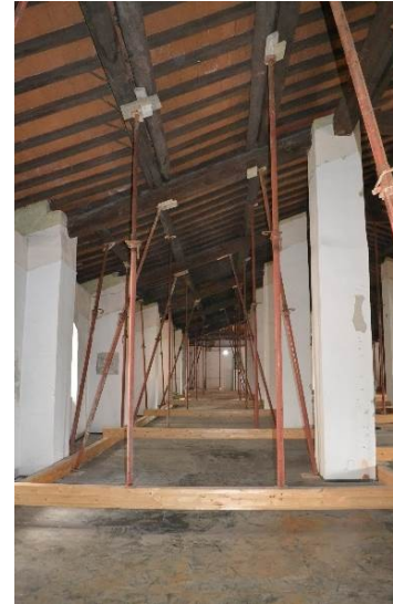
SITUAZIONE PRECEDENTE: interni
