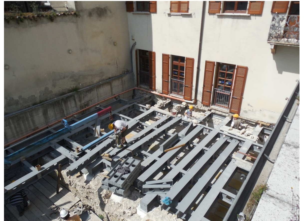
Le opere strutturali di copertura del cortile di Casa Pallaveri
