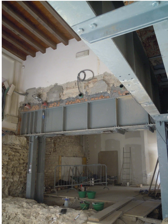
Le opere strutturali interne sotto le quote di Casa Pallaveri per la valorizzazione della IV cella
