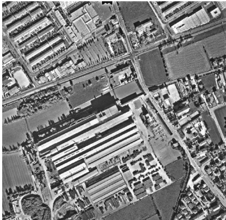
Dettaglio dello stabilimento nel 1995
