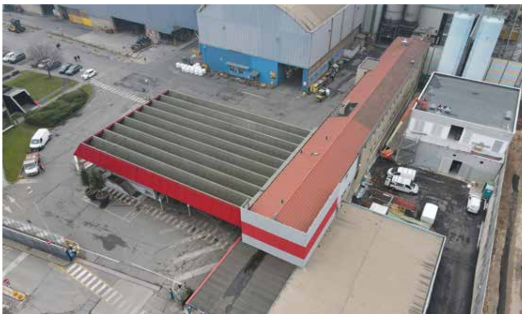
Lavori per la costruzione dell'impianto recupero calore
