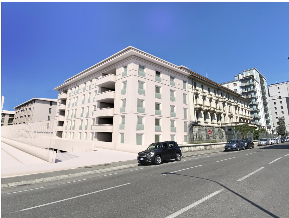
Via Vittorio Emanuele II – Edificio Residenza libera
