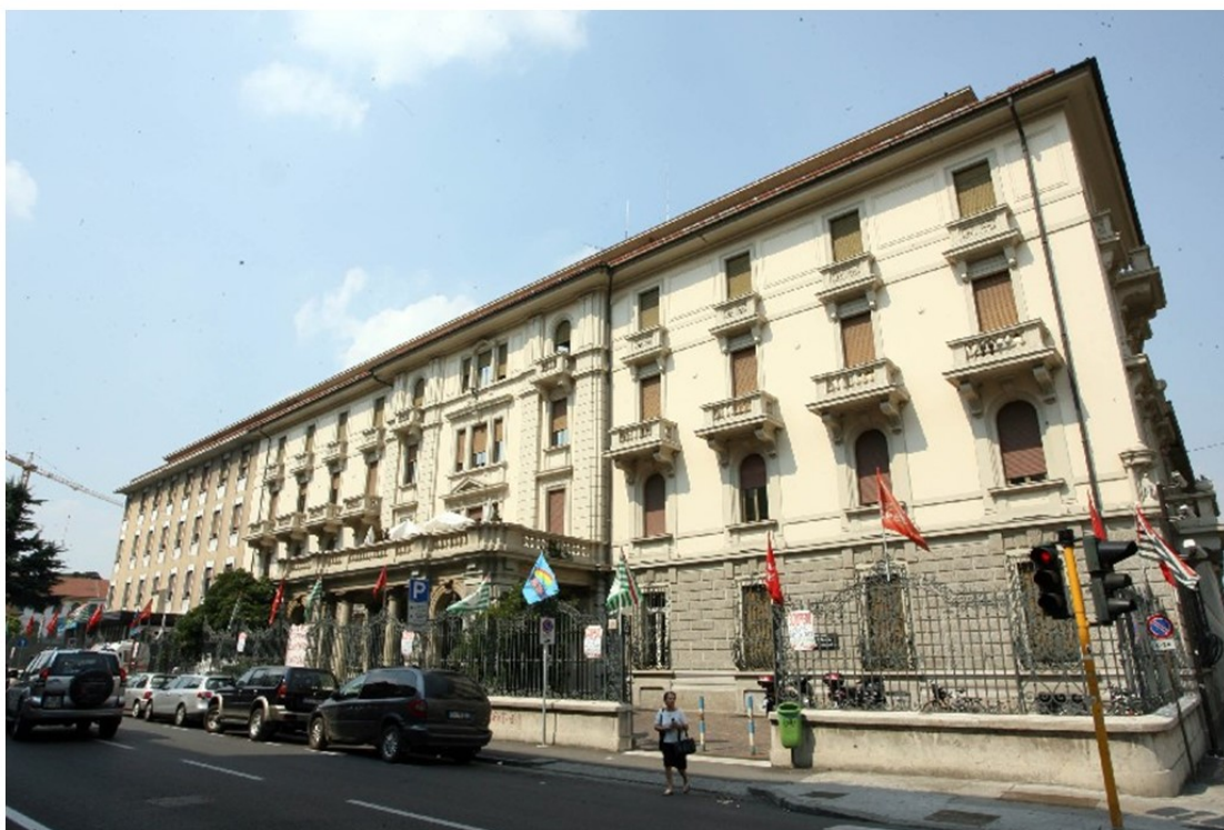
Foto 1 – Edificio storico Via Vittorio Emanuele II
