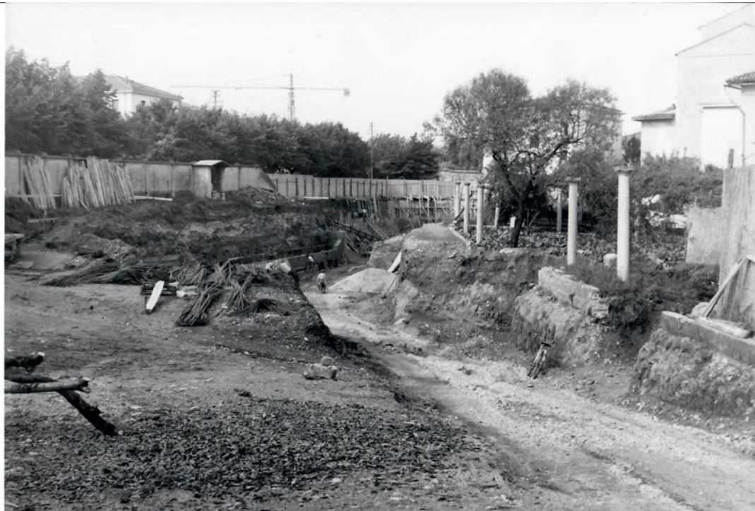
Scavo di fondazione e rampa di accesso al cortile
