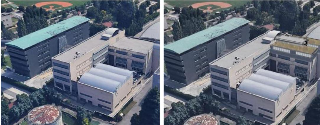
Figura 16 – fotoinserimento dell'intervento di sopralzo dell'edificio E70 "CSMT" – vista sud-ovest
