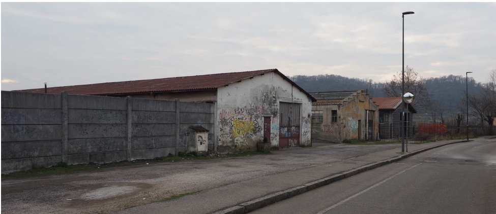
Allineamento dell'edificato in direzione ovest
