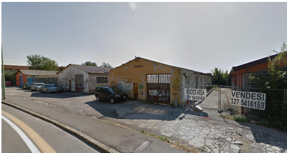
Figura 2.1 – Edifici esistenti in corrispondenza dell'area di intervento (sett. 2015 – Google Streetview)
