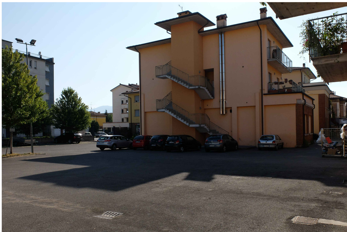
Foto 4. il corpo 2 da ovest
