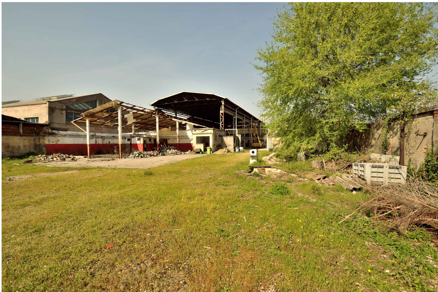
Foto 2. da sud verso i fabbricati dell'attività dismessa
