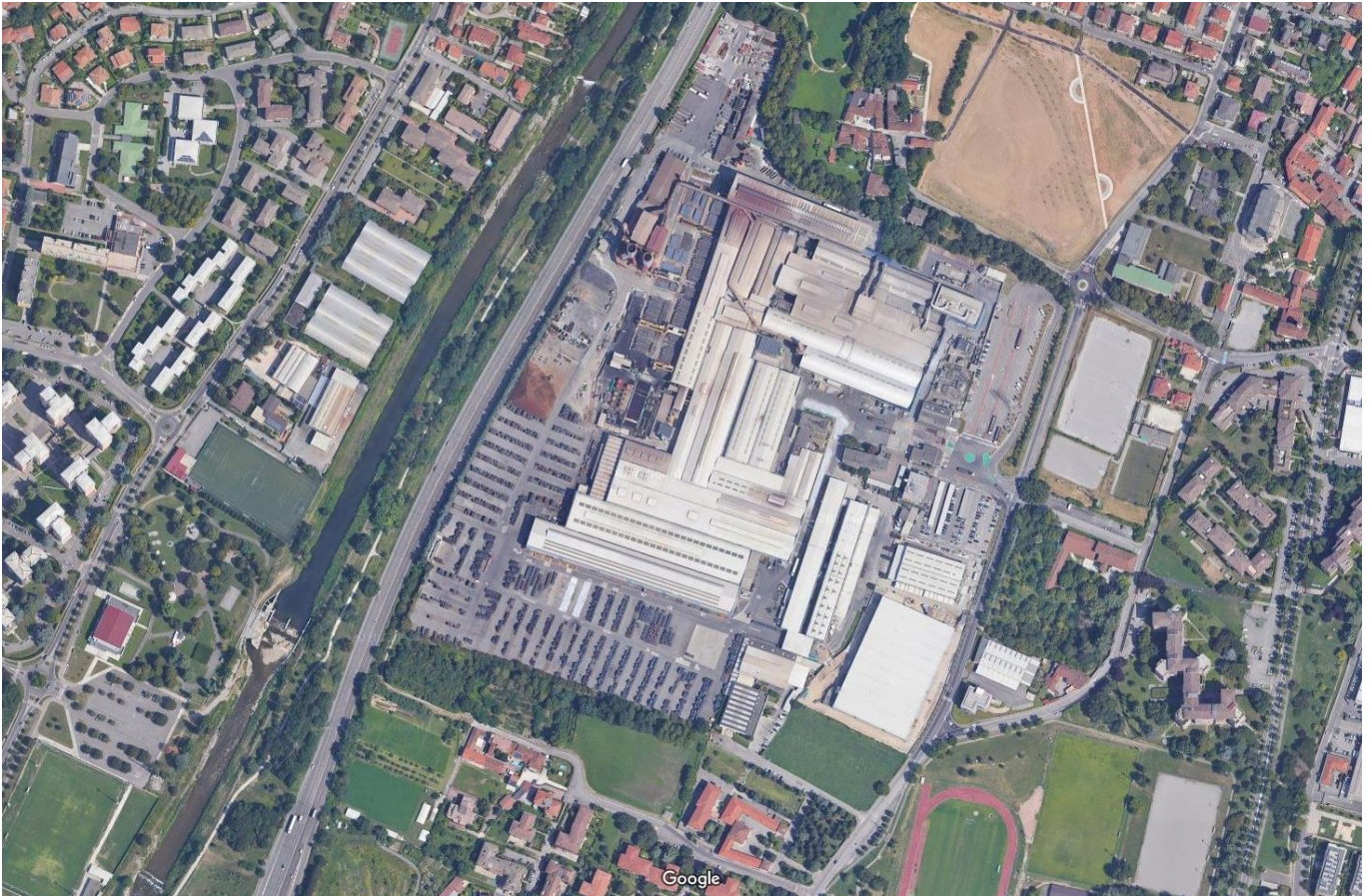
Vista aerea del Complesso Produttivo e del contesto ambientale al contorno.
