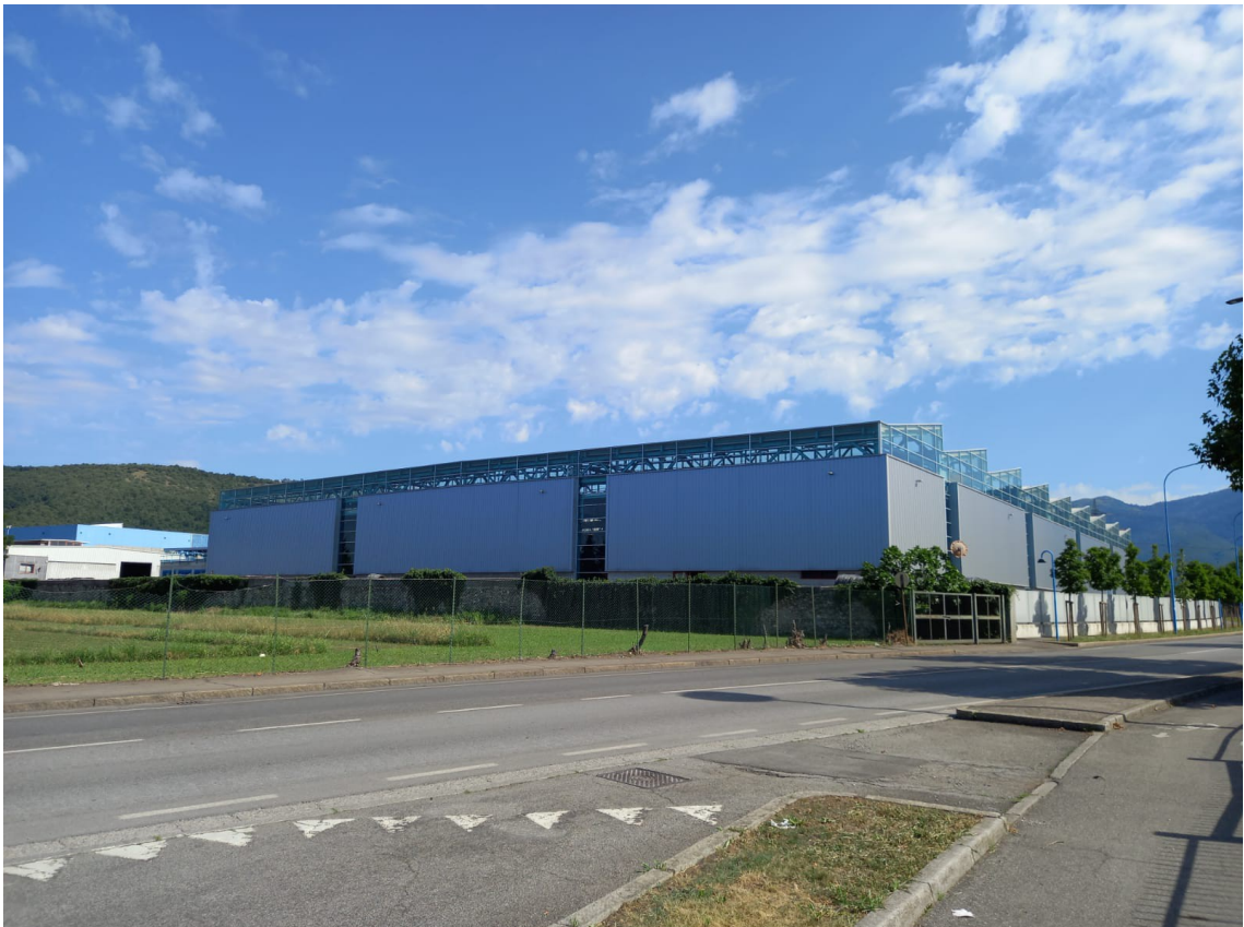
Vista del Complesso Produttivo verso sud nell'area ex FOMB (via Canovetti/via Scuole).
