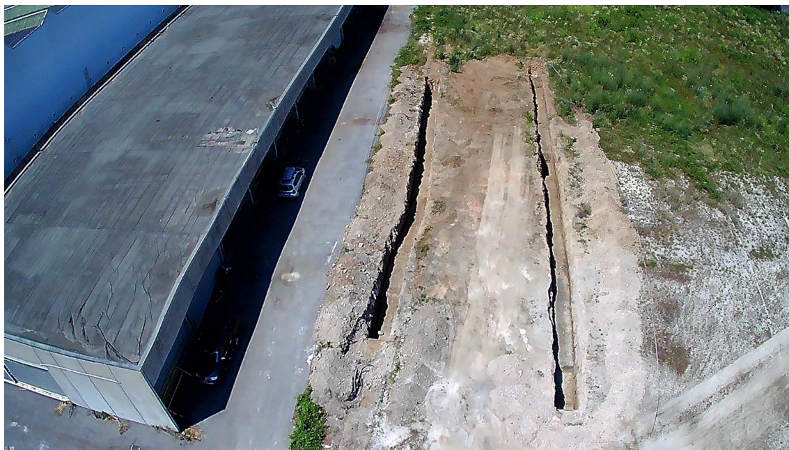
Fig.11 - Veduta aerea zona Sud: Tr.1 e Tr.2
