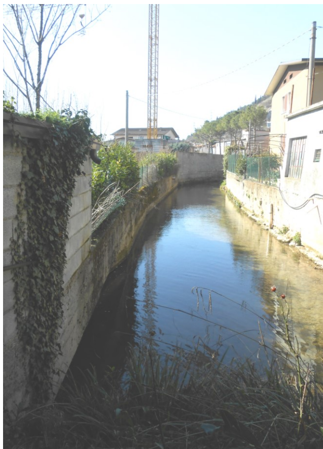
Immagine 8 - vista del canale- interruzione percorso
