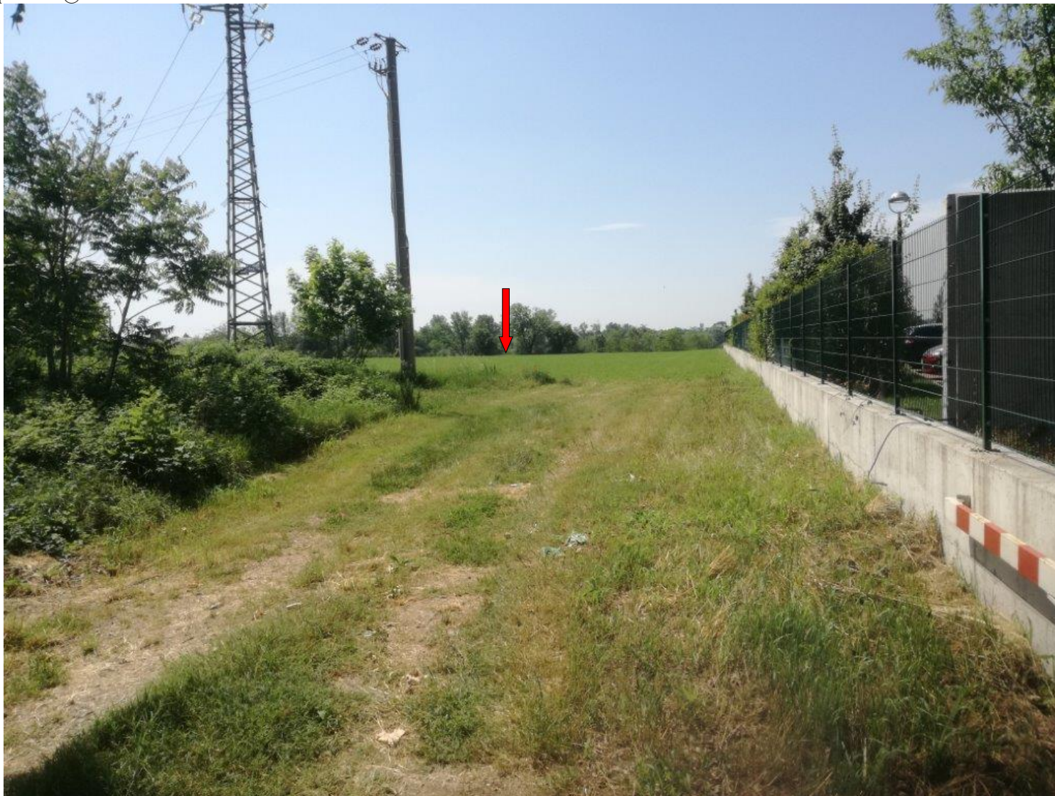
FOTO 2) INGRESSO AREA - LATO ATTUALE RECINZIONE CEMBRE
