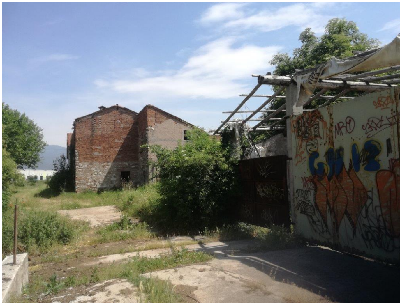
FOTO 5) VISTA DELLA CASCINA
