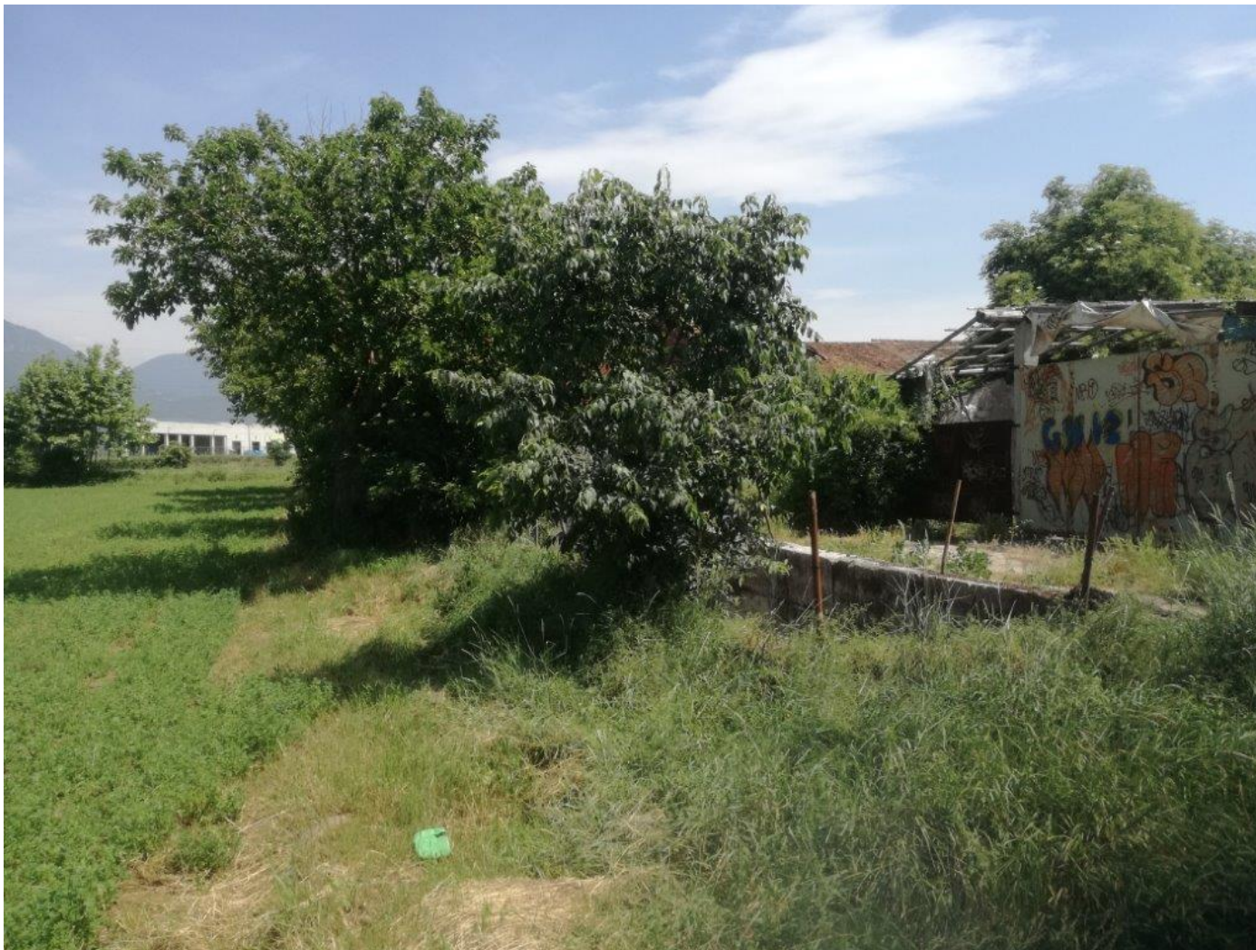
FOTO 4) VISTA DELLA CASCINA
