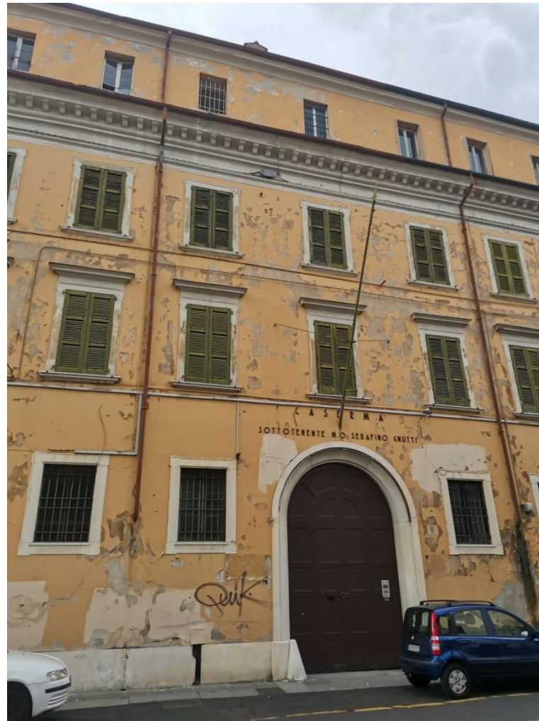
facciata del corpo principale in via Crispi
