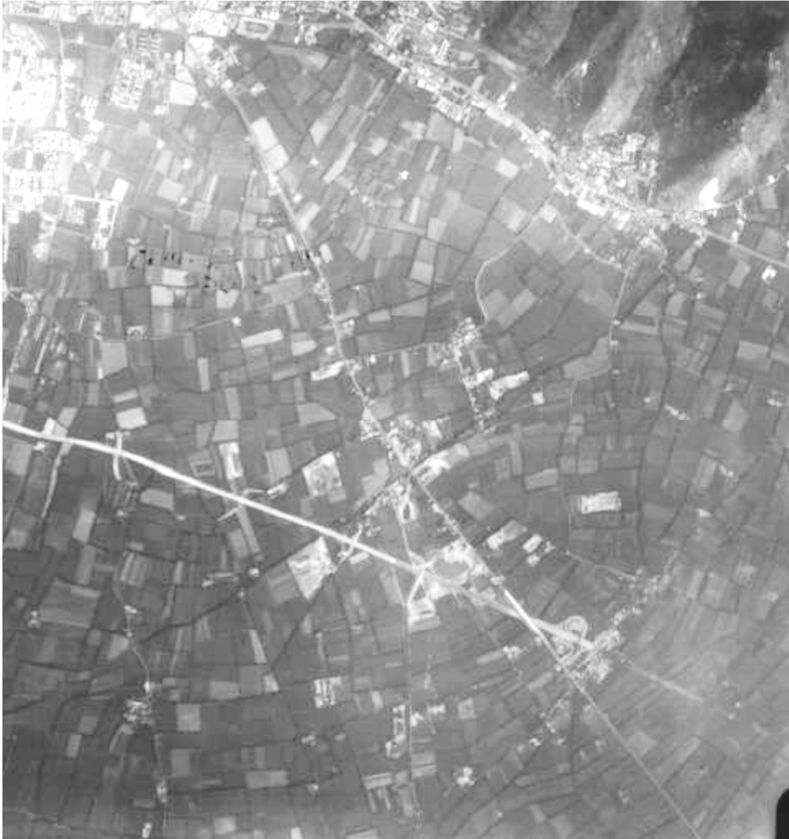
1958 – L'autostrada A4 Milano Venezia è in fase di costruzione. L'Alfa Acciai è presente dal 55' con il primo forno fusorio.
