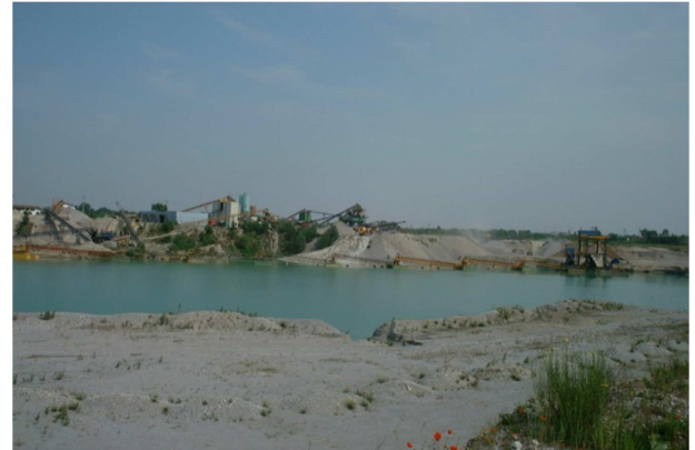
Ripresa 6 – La situazione degli impianti prima dell'intervento di recupero ambientale
